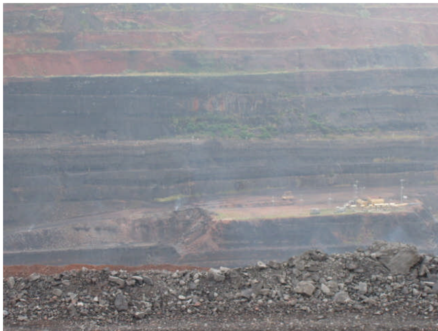
Figura 23. Imagen de la zona 5, se observa en proceso de apagamiento. Fuente: Elaboración Propia, (12/01/05).
