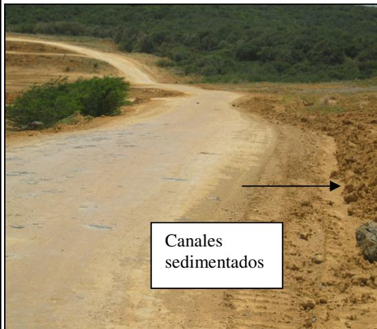
5. Ausencia y/o deficiencias de canales de drenaje longitudinales totalmente sedimentadas en algunas partes del tramo. (ver foto # 24)
