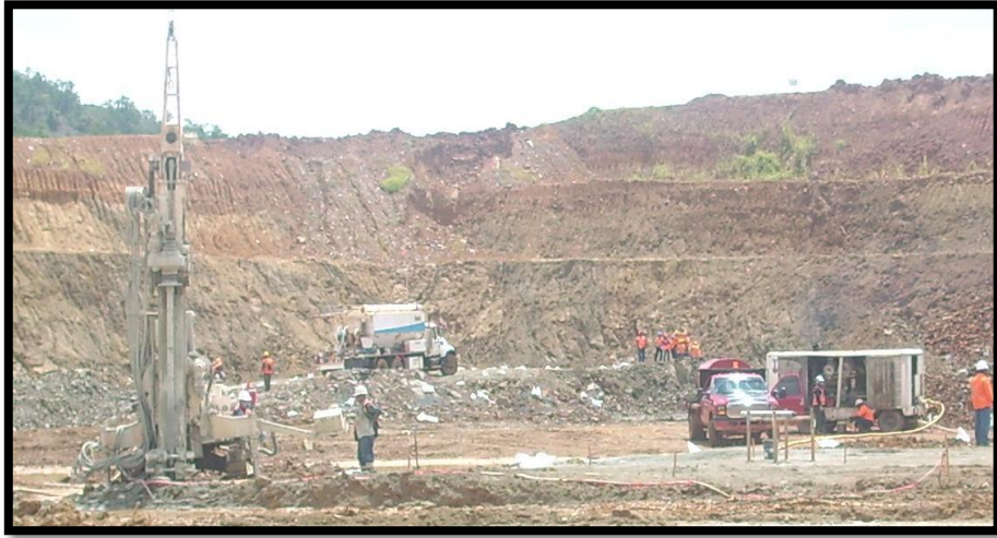
Figura N° 33 Labores de carga en frente de Voladura (fuente propia)
