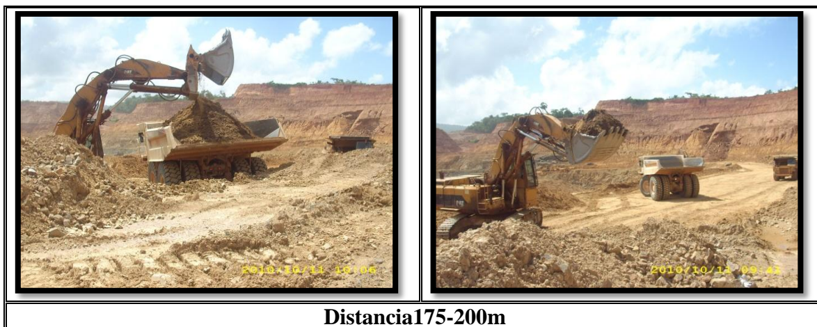
Figura N° 45 Secuencia de Evaluación por Tramo Voladura N° 22 (Fuente Propia)
