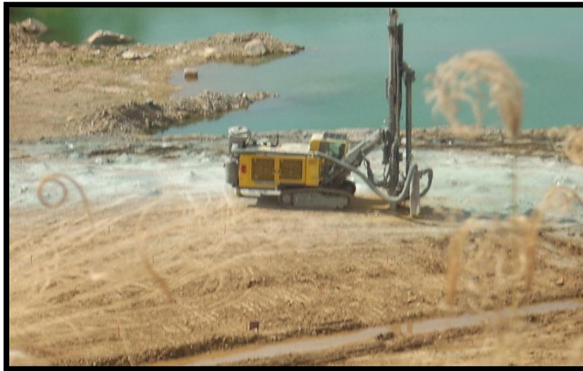
Figura N° 32 Perforación de Barrenos (fuente Propia)
