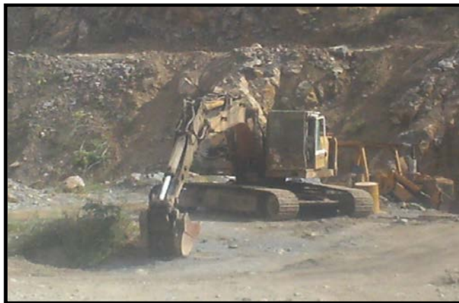
Figura N° 33 Excavadora Hidráulica CAT 330BL. Tomado en Cantera las Marías (2011)
