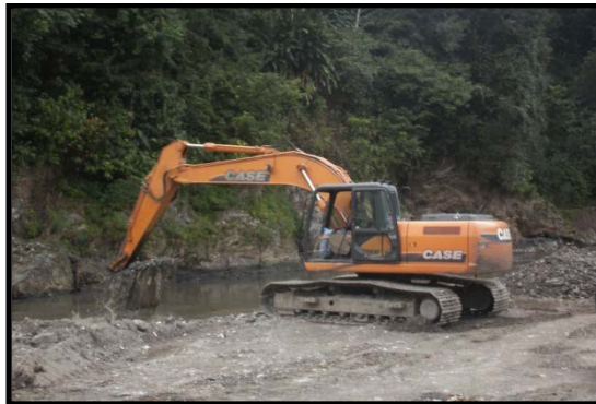
Figura N° 21. Excavadora de oruga Case. Tomado en Casalbeach (2011)
