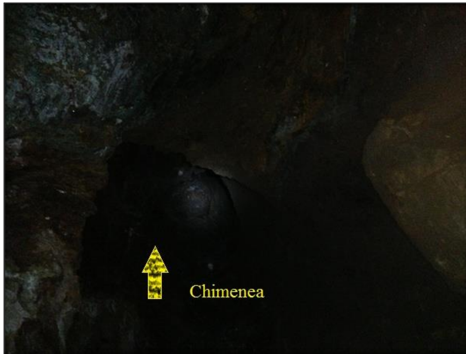
Figura 68. Fotografía de la chimenea de descarga de material. Autora: Dulce Barrera (2013)
