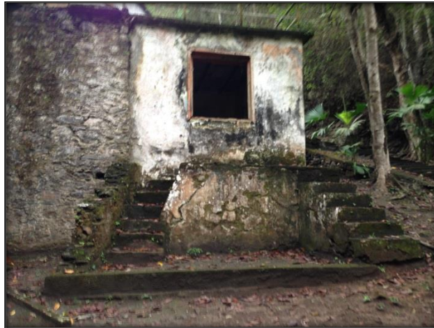
Figura 61. Fotografía del edificio de topografía. Fuente propia (2013)
