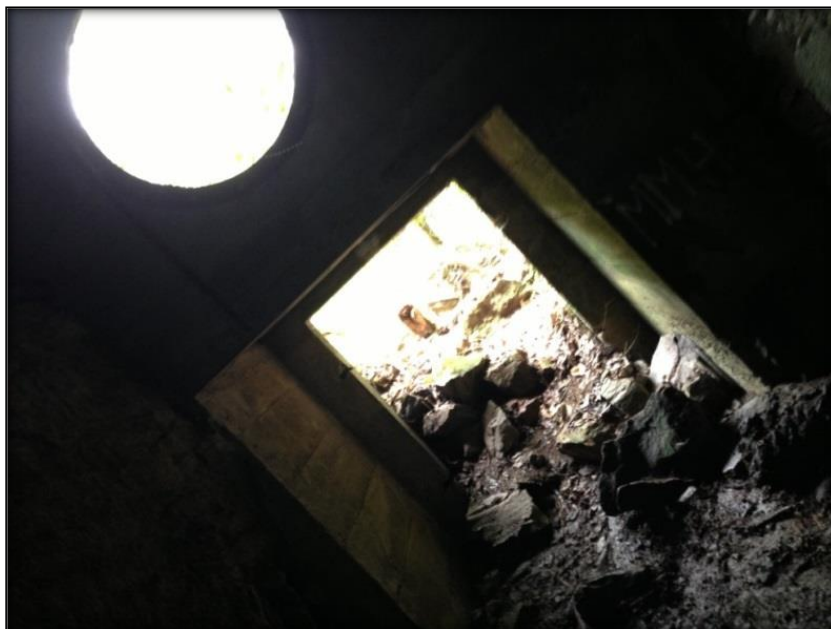
Figura 22 Portal de acceso a la Galería San Antonio. Fotografía Jesús Salazar (2012)
