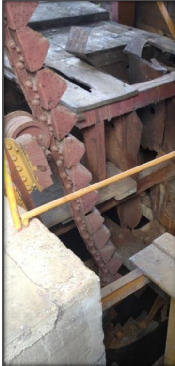
Figura 51. Fotografía de la cinta transportadora con cangilones. Fuente propia (2013).
