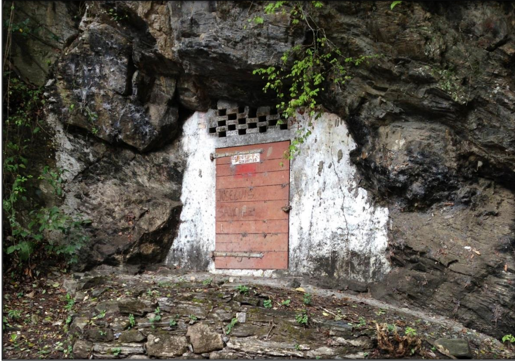
Figura 56. Fotografía del depósito de dinamitas. Fuente propia (2013).
