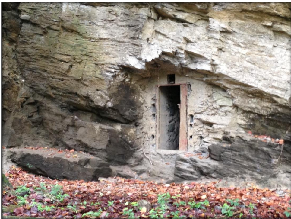
Figura 57. Fotografía del depósito de mechas. Fuente propia (2013).
