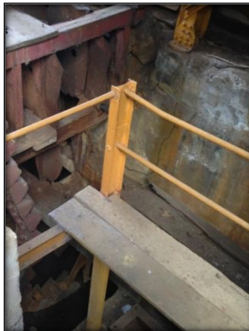
Figura 50. Fotografía de la tolva de almacenamiento mineral. Fuente propia (2013).
