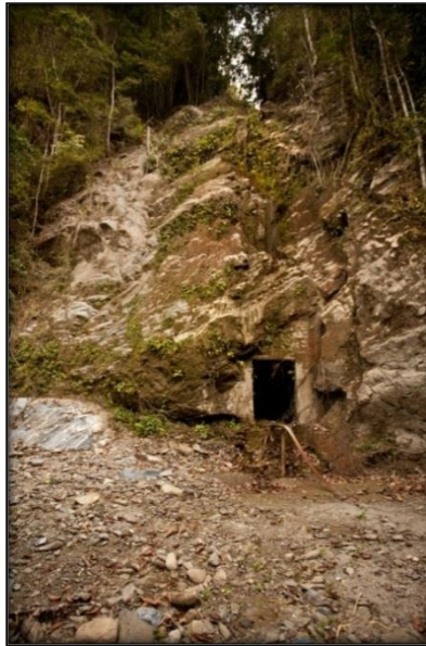
Figura 21 Portal opcional de entrada a galería San Antonio. Fotografía Jesús Salazar (2012)
