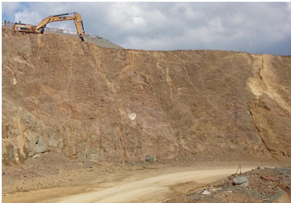
Figura 211. Talud de la zona 1-R (fuente propia)
