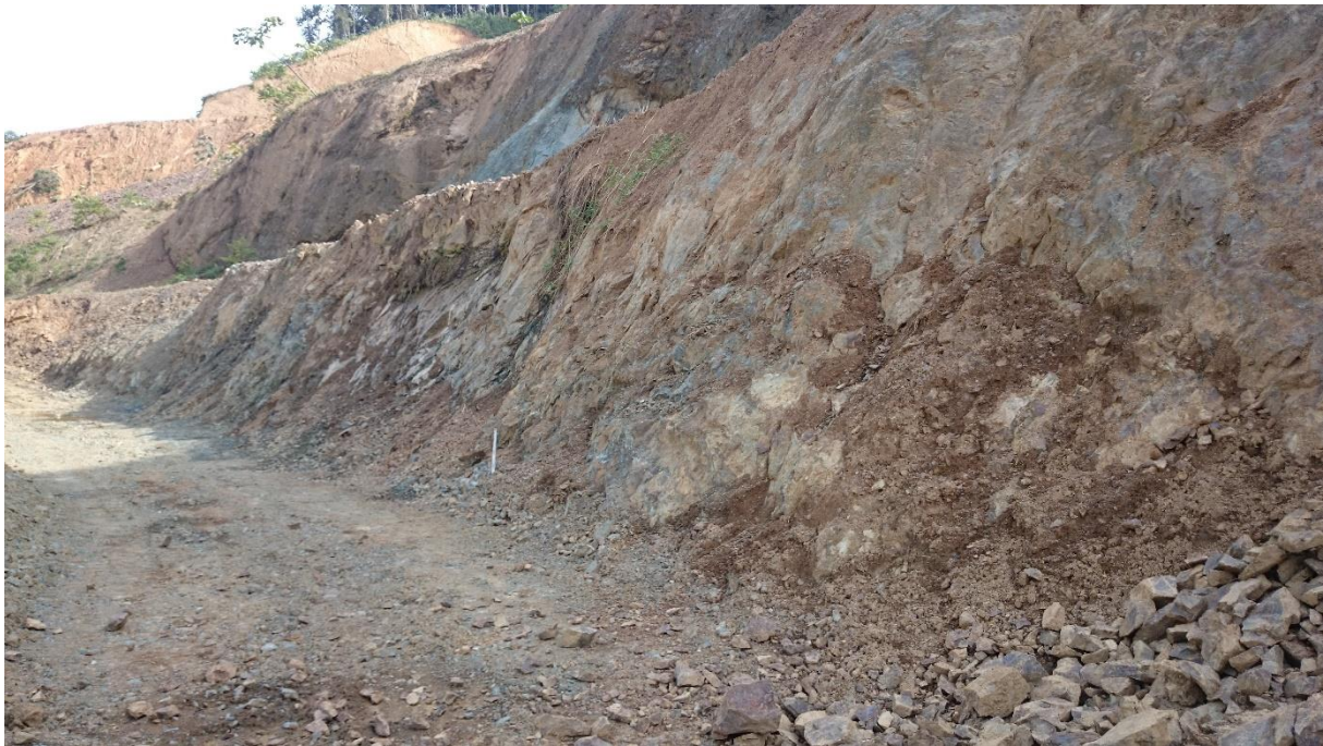
Figura 227. Talud de la zona 13-L (fuente propia)
