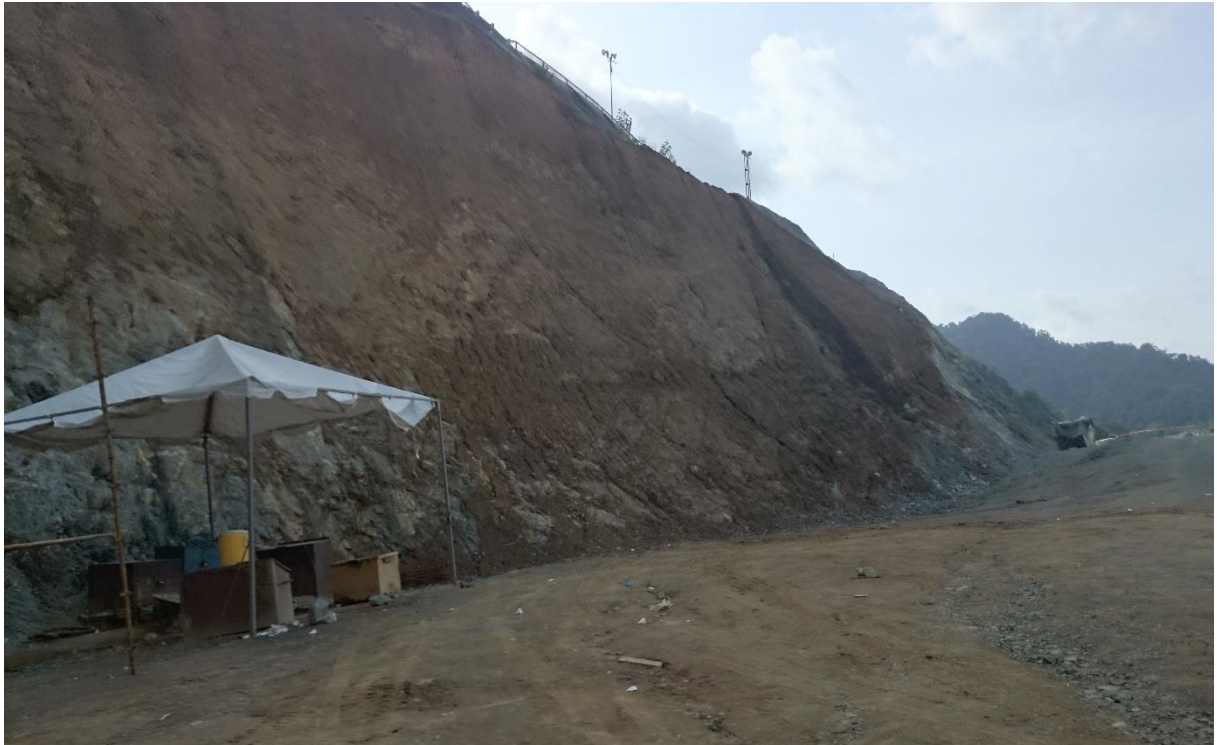
Figura 220. Talud de la zona 5-L (fuente propia)
