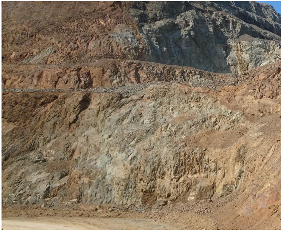
Figura 214. Talud de la zona 4-R (fuente propia)
