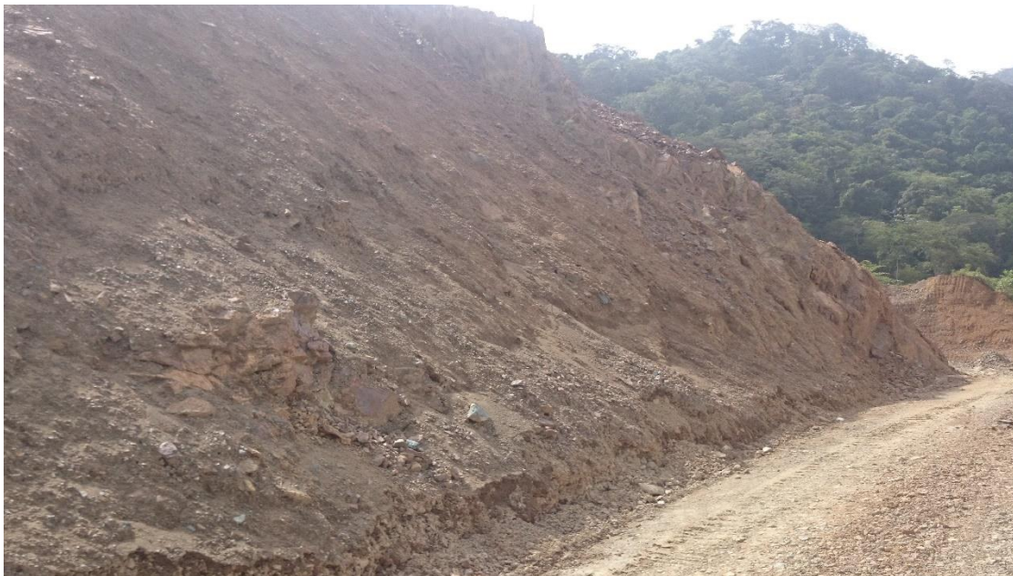
Figura 225. Talud de la zona 10-L (fuente propia)
