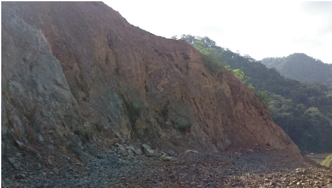
Figura 226. Talud de la zona 12-L (fuente propia)
