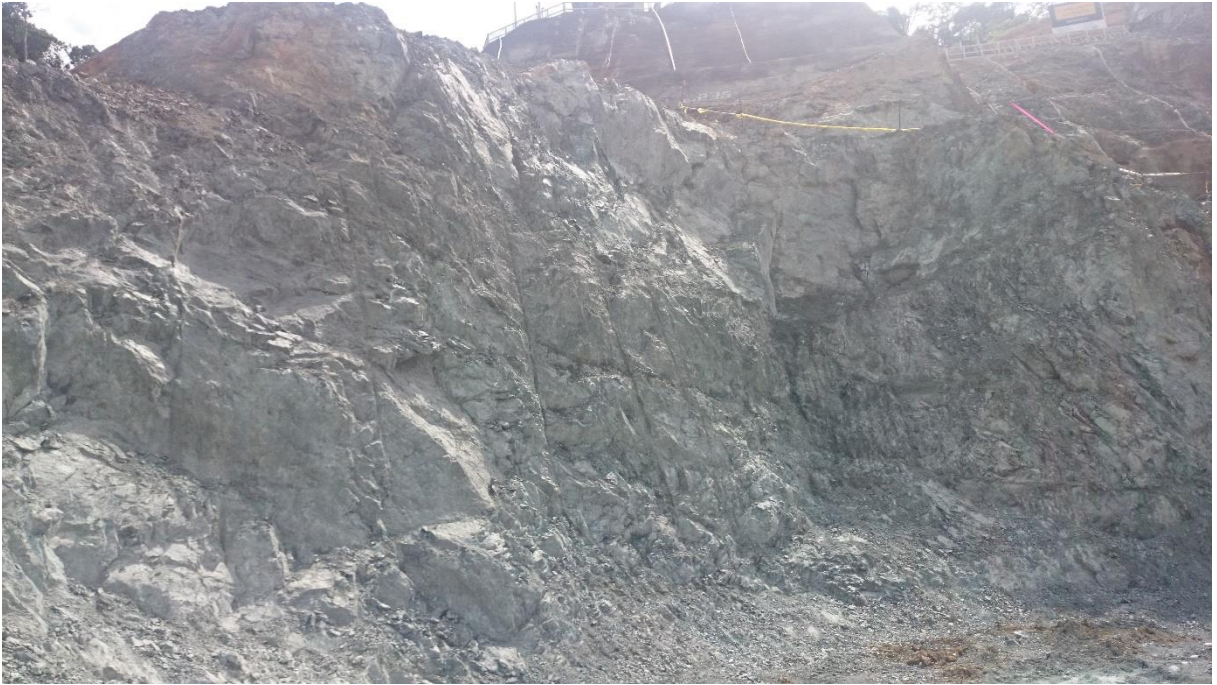
Figura 224. Talud de la zona 9-L (fuente propia)
