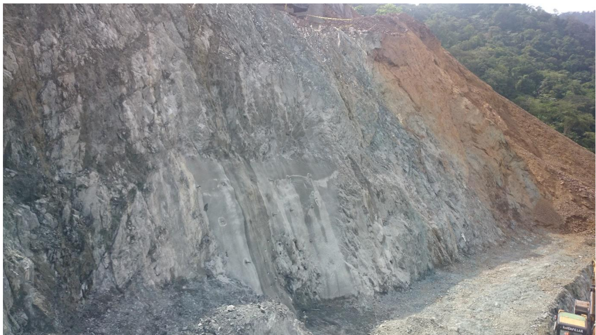
Figura 223. Talud de la zona 8-L (fuente propia)
