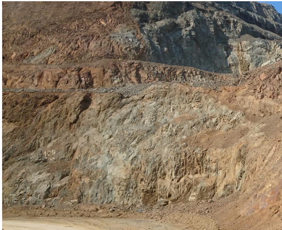
Figura 213. Talud de la zona 3-R (fuente propia)
