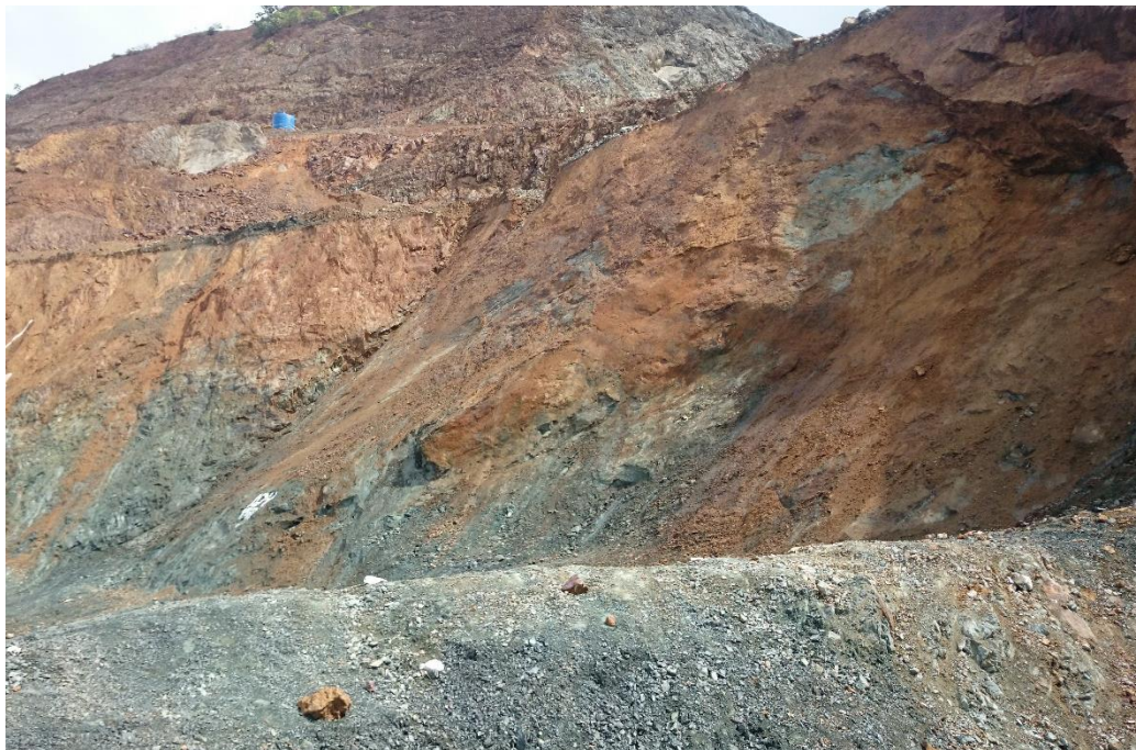
Figura 217. Talud de la zona 9-R (fuente propia)
