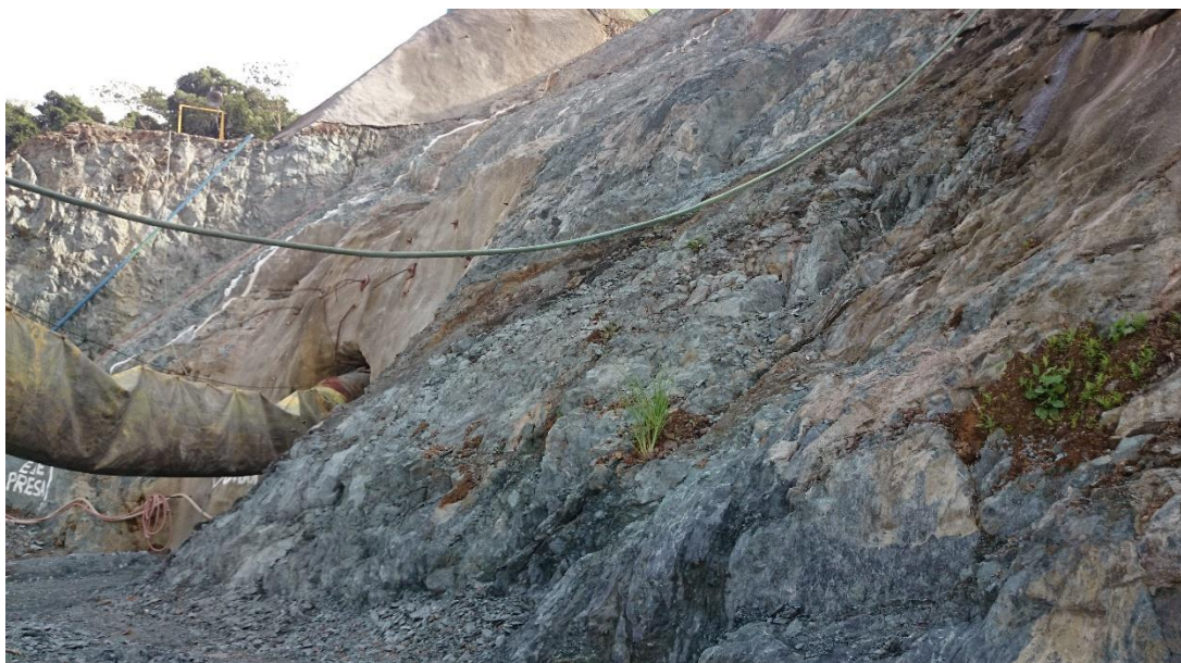
Figura 219. Talud de la zona 4-L (fuente propia)
