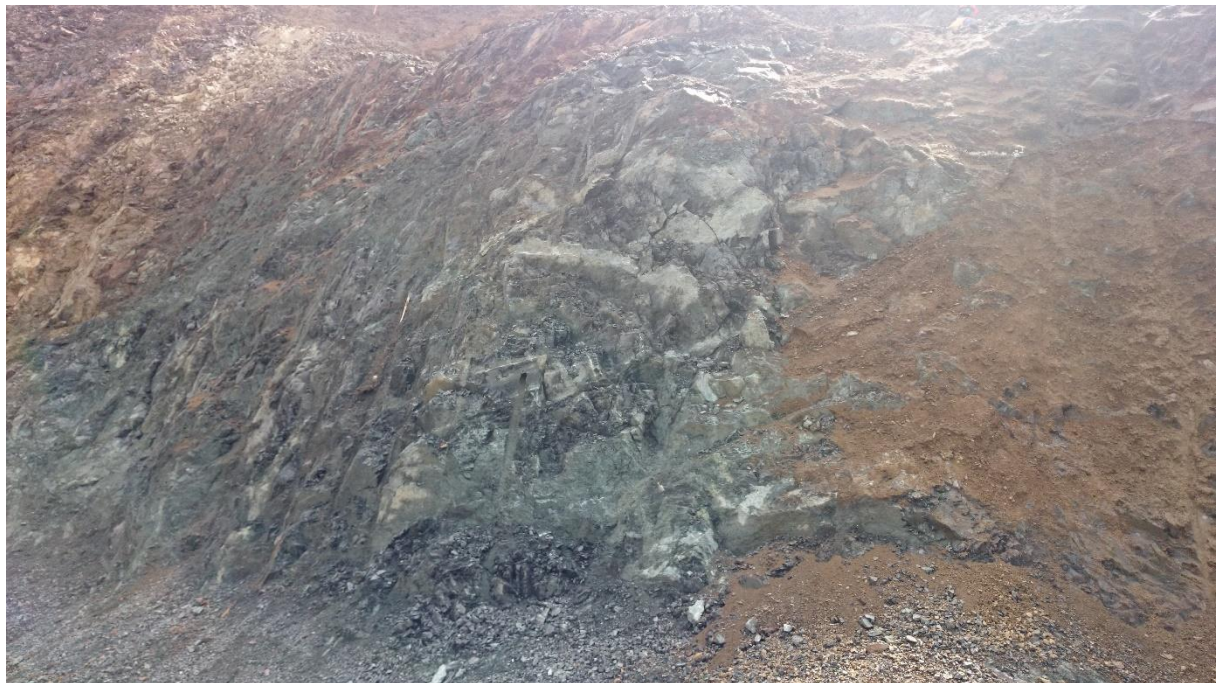
Figura 216. Talud de la zona 8-R (fuente propia)
