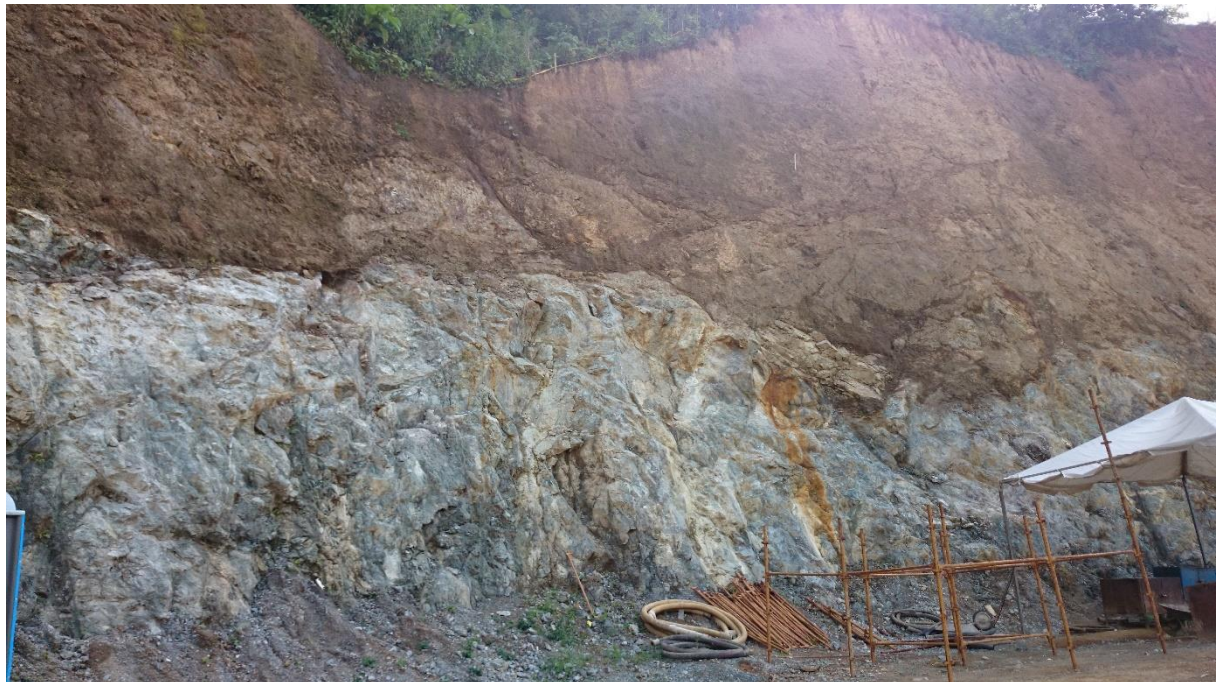
Figura 221. Talud de la zona 6-L (fuente propia)
