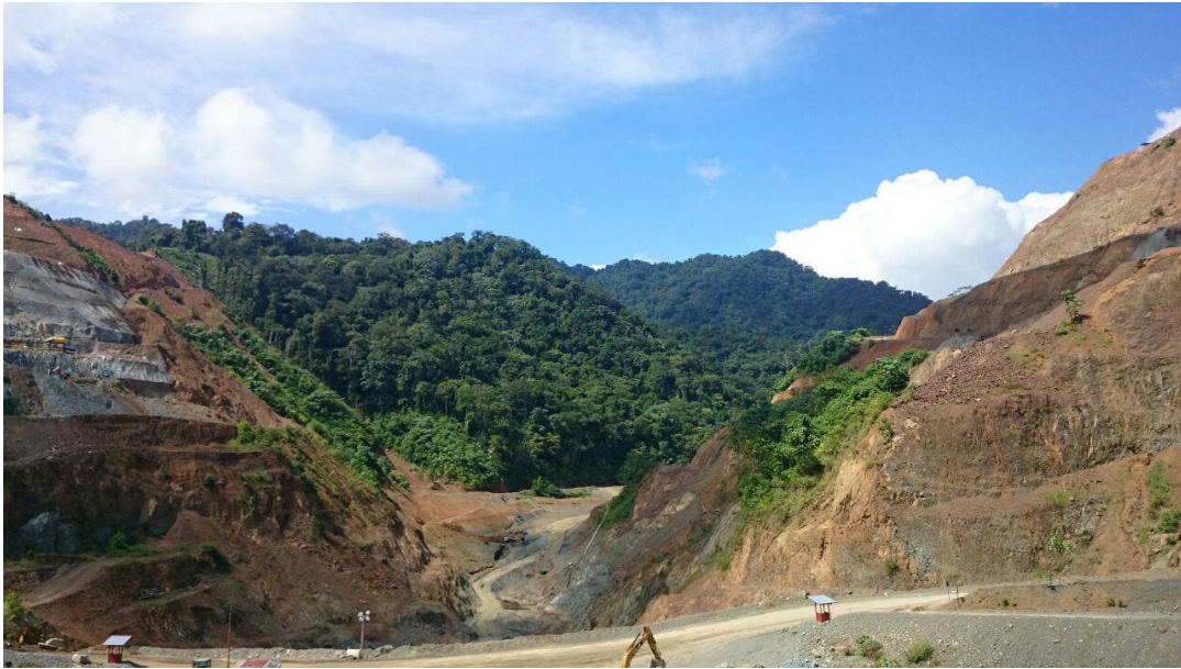
Figura 3. Zona de la presa sobre el río Cuira (fuente propia).
