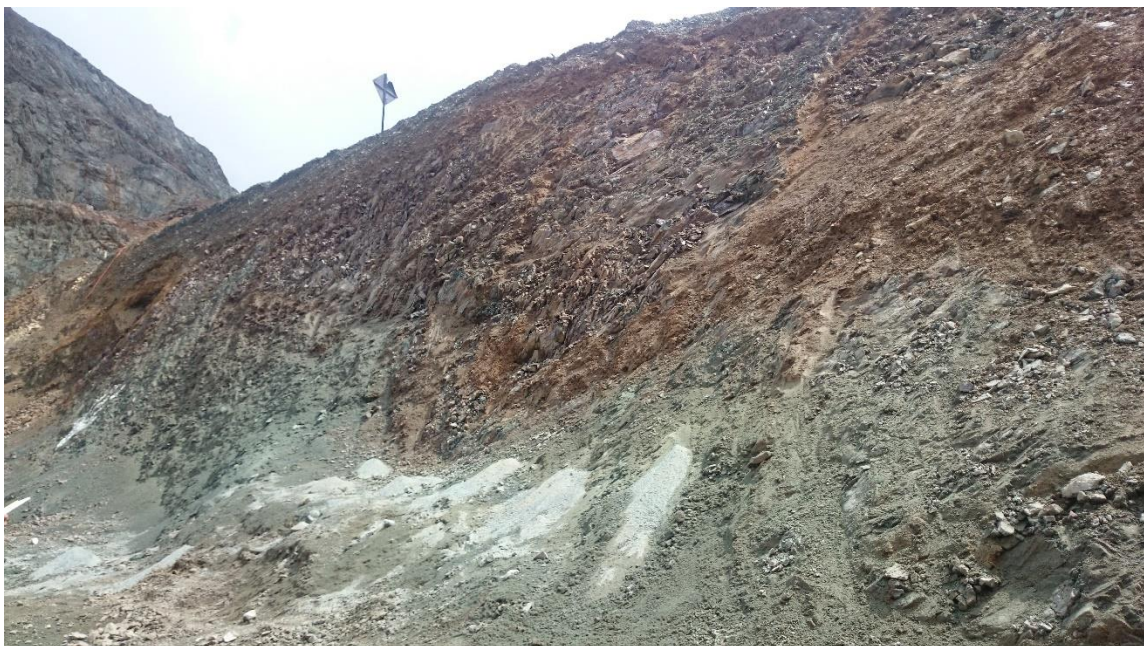
Figura 215. Talud de la zona 7-R (fuente propia)
