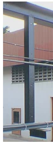
Figura 41. Soporte de la línea de vacío
