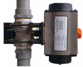
Figura 37. Válvula con conectores principal de vacío
