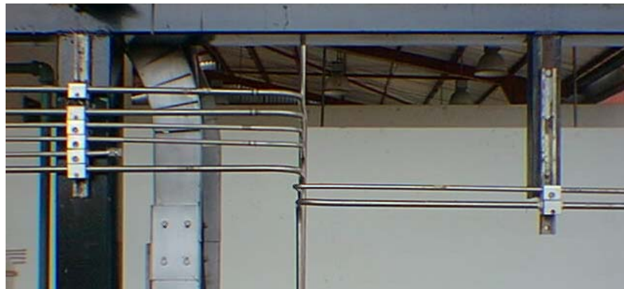
Figura 44. Tendido mejorado de las tuberías externas del Panel 941
