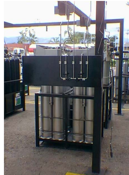
Figura 18. Vista Frontal del Sistema de Suministro de CO 2
