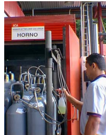
Figura 8. Prueba de Fuga en un Proceso de Tratamiento
