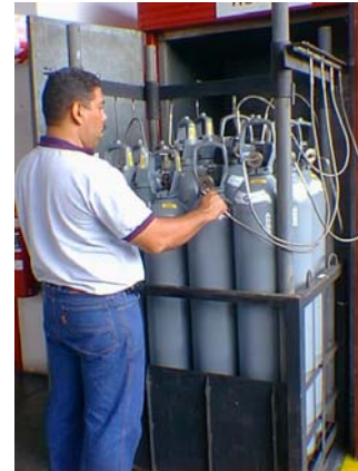
Figura 9. Desmontaje de un Proceso de Tratamiento
