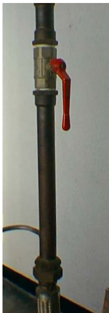
Figura 30. Estructura Original de la Línea de Vacío
