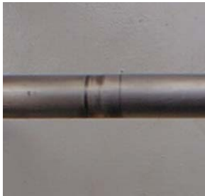
Figura 32. Tramo de tubería soldado
