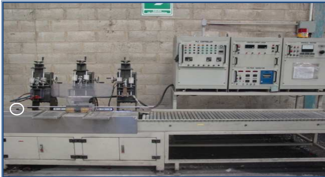
Figura F. Sensor de baterías.
