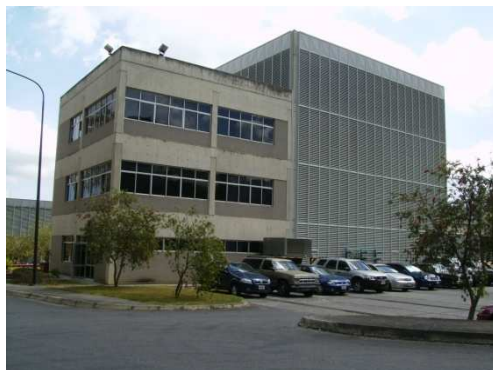
Figura A.1. Edificio Norte 6 PDVSA-INTEVEP (Ubicación del CSGL) Fuente: PDVSA-INTEVEP, (2008)
