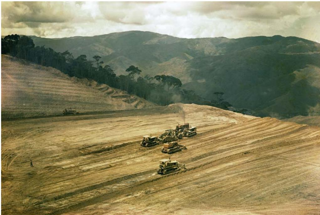
**Imagen 4: movimientos de tierra para la construcción de las primeras infraestructuras del IVNIC. Nota. Imagen cedida por Fotografía Científica IVIC.**
