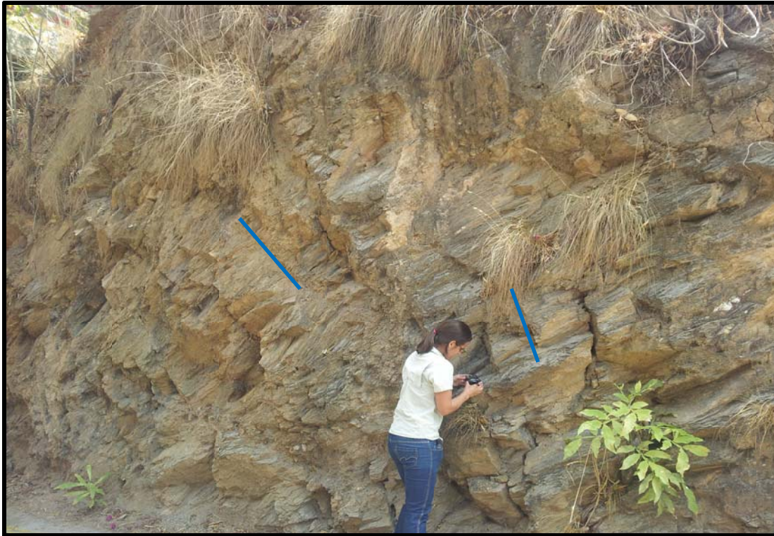
Figura 25. Afloramiento 9, se observa su grado de meteorización y las líneas azules representan planos de diaclasas.
