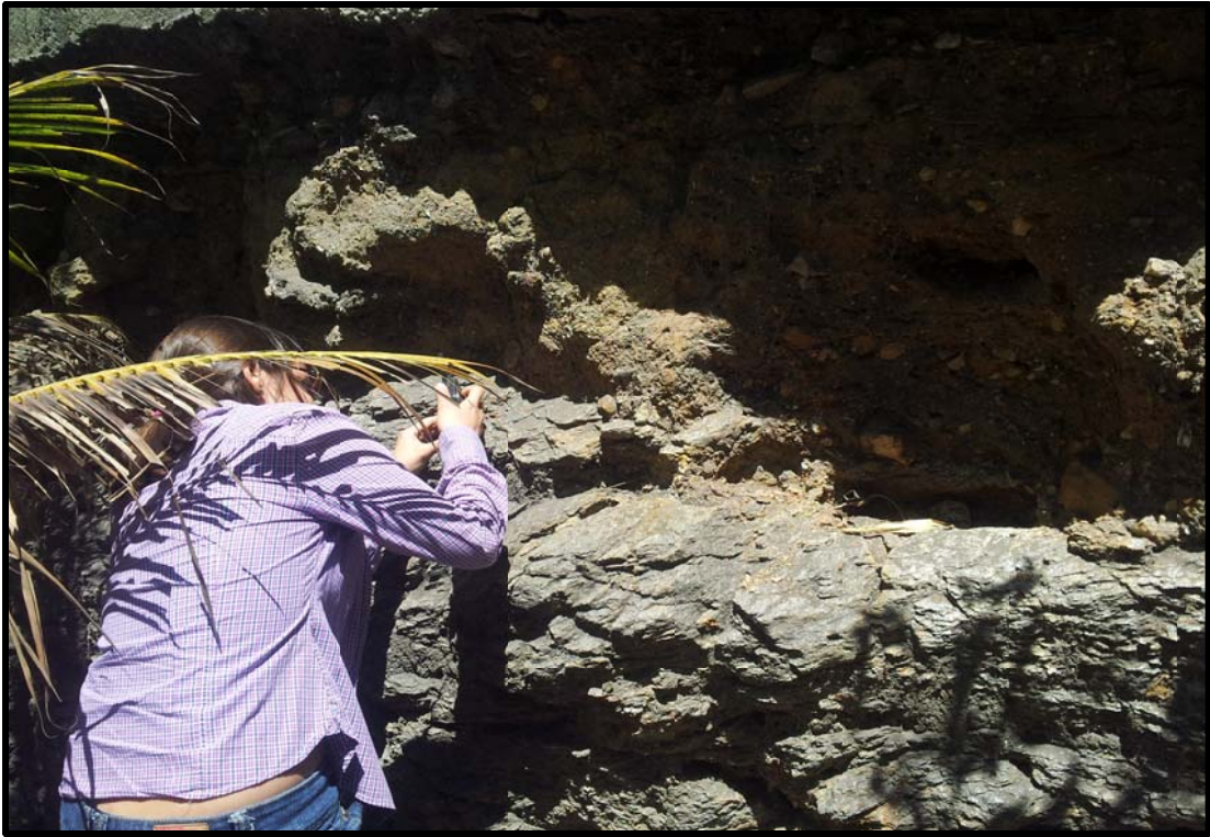
Figura 23. Afloramiento 7, se observa el relleno ubicado en la parte superior.
