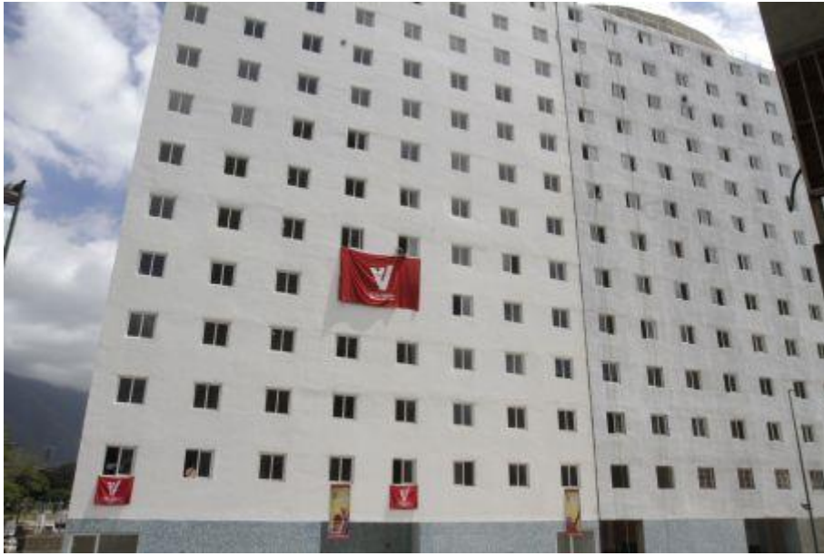
Figura 2: Fachada del Urbanismo Carlos Escarrá.
