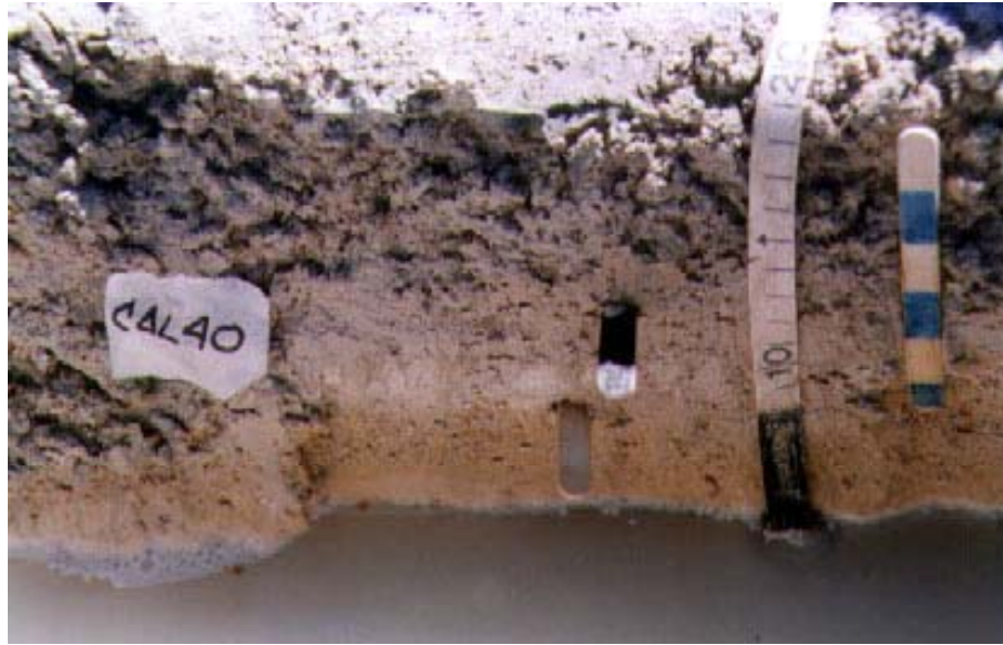
Figura 4.3. Fotografía de la calicata 40 donde se observa a la facies F1 en las capas superiores ricas en limos y cristales de yeso
