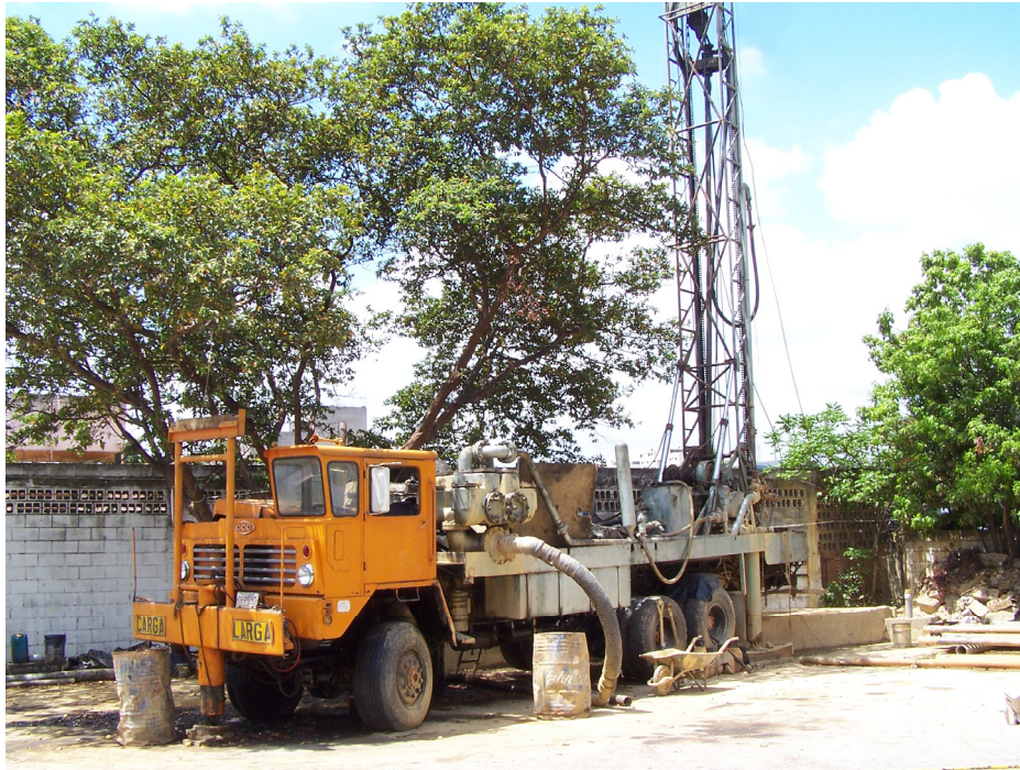
Figura 4. Perforación del pozo ubicado en la Escuela de Enfermería de la UCV, Sebucán.
