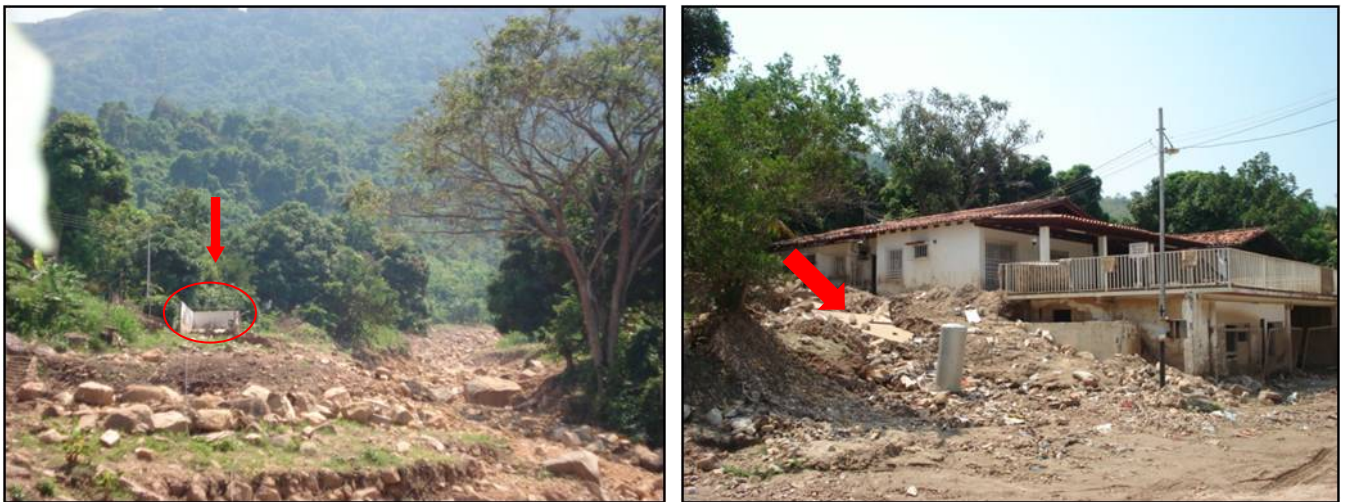
Figura 2 La fotografía de la izquierda muestra Vivienda devastada por la crecida, la fotografía de la derecha muestra una vivienda menos afectada por estar fuera del cauce principal de la quebrada pero dentro del área de inundación. Fuente: Ministerio del Poder Popular para el Ambiente.
