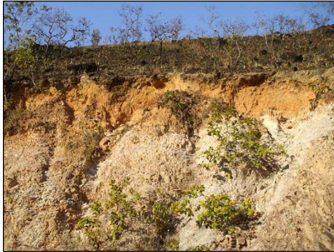
Figura 32 Movimientos complejos (caída de bloques, flujo de detritos y deslizamiento translacional).
