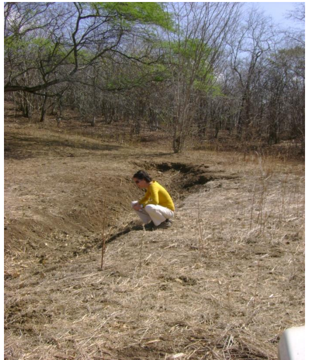
Figura N° 3.4. Cárcava con orientación N 30° E Ubicada cercana a la progresiva 313+000
