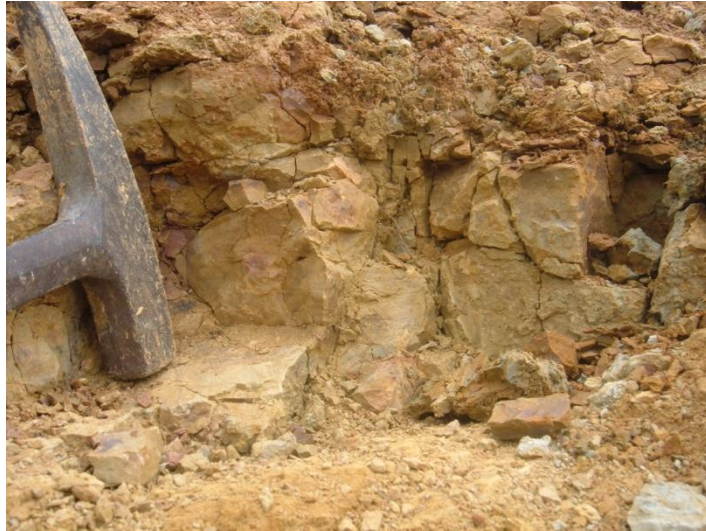
Figura N° 3.16. Arcilita altamente diaclasada, localizada en la progresiva 354+000. (Orientación S 39° E).
