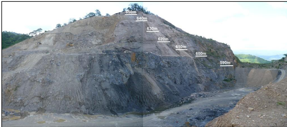
Figura 2 Foto Niveles del frente de explotación norte de la cantera Mume, vista hacia NE
