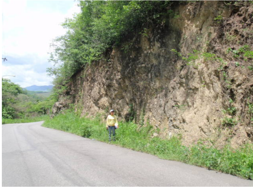
Figura 5.32: Foto que muestra talud 2, ubicado en la progresiva 69+580 y corresponde al portal este de túnel.
