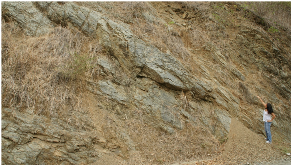
Figura 5.35: Foto que muestra caído de bloques donde el material involucrado está compuesto por una combinación de roca y detrito. Ubicada en las cercanías del pueblo de tacatá. Punto LCT 47
