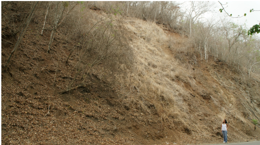
Figura 5.34: Foto que muestra caído de bloques donde el material involucrado está compuesto por una combinación de roca, detrito y suelo. Se observa arrastre de la cobertura vegetal. Ubicada en ladera de la progresiva Km 58+080 en el pueblo de Túcata, en la carretera que va desde Túcata hasta Altagracia de la Montaña
