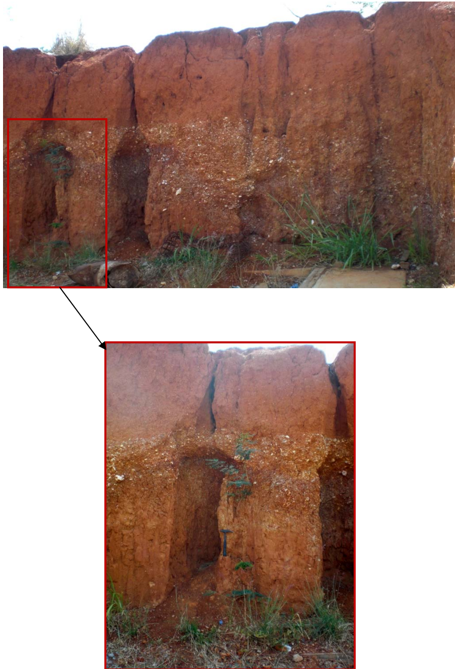
Figura 5.39: Fotos que muestra cárcavas ubicadas en la urbanización colinas de Santa Bárbara, en el sector Aparay, de Cúa. Foto superior: vista general, Foto inferior: detalle de las cárcavas.
