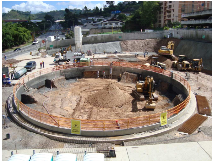
Foto 5.1 Detalle del Foso la Macarena Sur, excavación Anillo 2. SALOMÓN, 2008.
