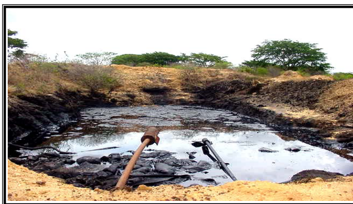
Figura N° 4. Muro Quemador ubicado en el Estado Monagas
