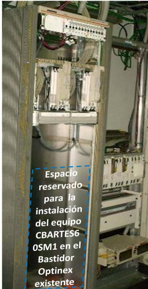
Figura 13: Posición seleccionada para multiplexor Alcatel-Lucent 1660 en Bellas Artes.
