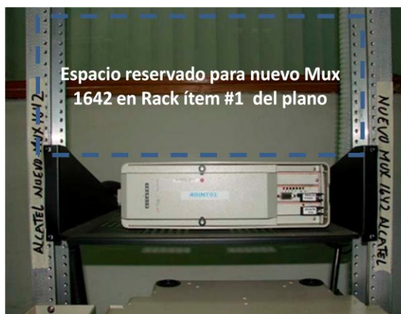
Figura 23: Espacio reservado para Mux 1642 en Intertron.
