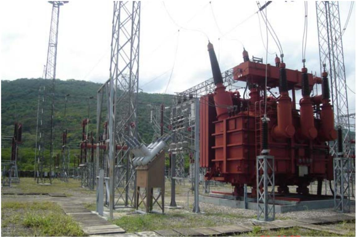
Foto 1 Autotransformador y Terciario
