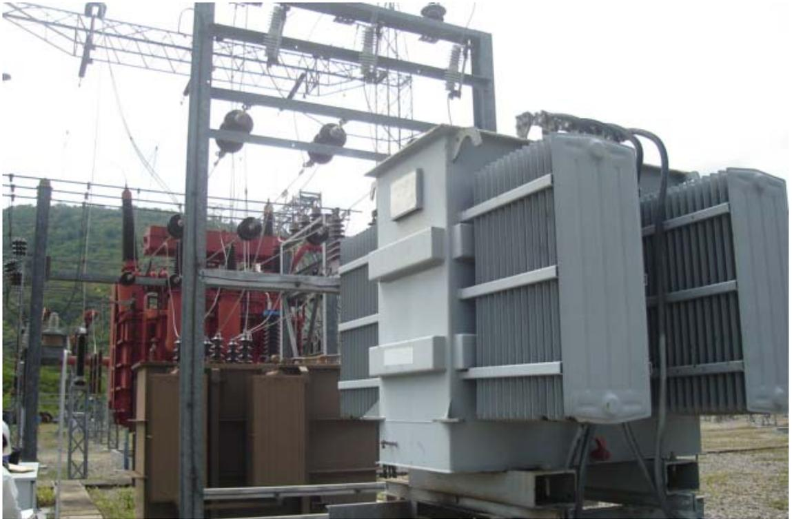
Foto 3 Transformador de Servicios Auxiliares 13,8/0.48 kV alimentado por Terciario del Autotransformador.
