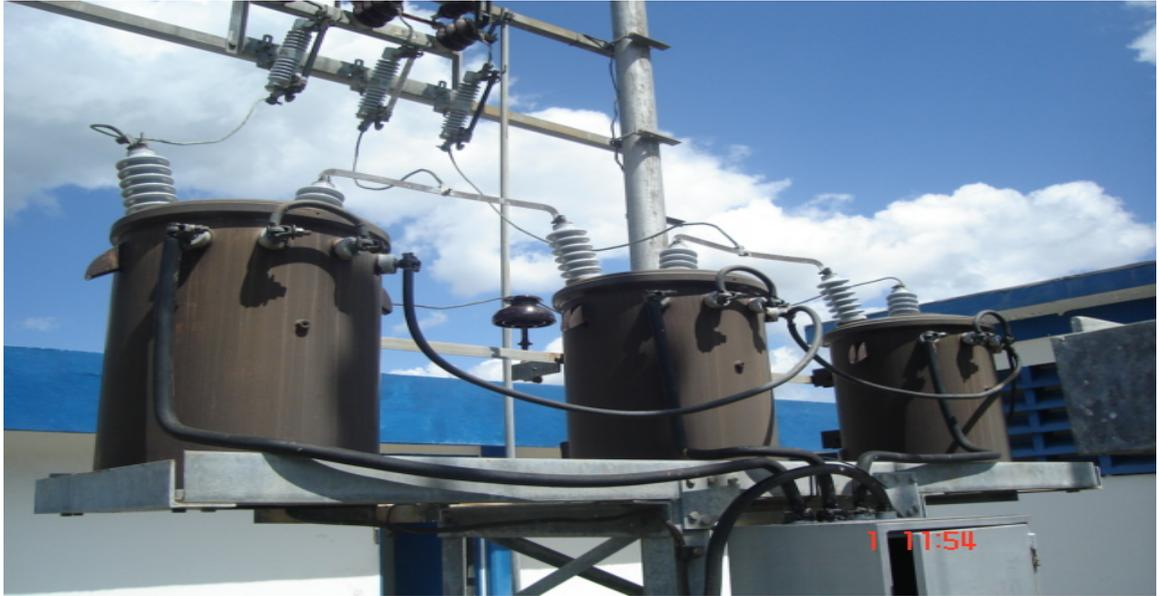
Foto 5 Banco de Transformadores de Servicios Auxiliares alimentado de línea de media tensión exterior.
