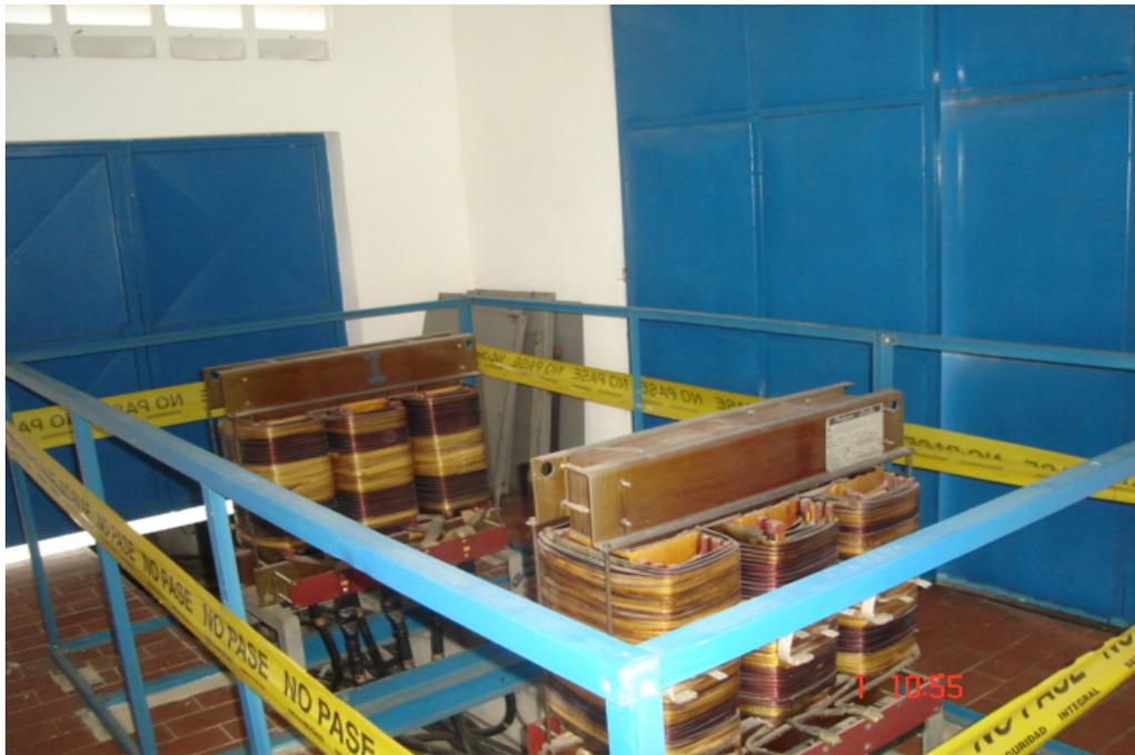
Foto 4 Transformadores secos de Servicios Auxiliares a 480/208 V
