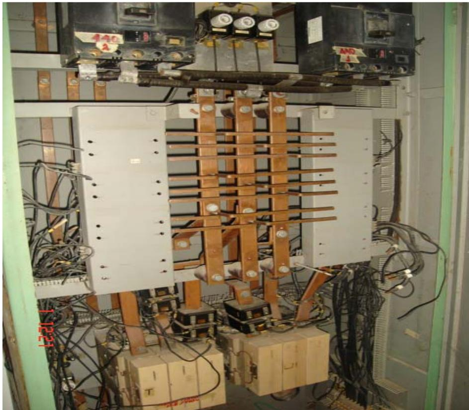
Foto 6 Tablero de Servicios Auxiliares a 480V
