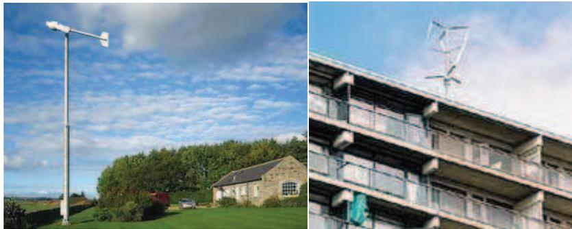
Figura 15. Modelo de un aerogenerador horizontal y vertical.
