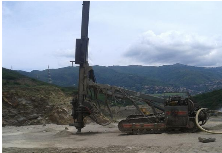
Figura 33. Equipo de perforación Gardner Denver . Fuente: Cantera Carayaca (2014).
