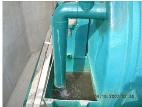
Figura 10. Clorador y tuberías. Pastillas de cloro aplicadas para la desinfección.
