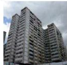
2. PCAP. Pórticos de concreto armado rellenos con paredes de bloques de arcilla o de concreto.
