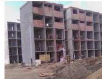
4. MCA1D. Muros de concreto armado de poco espesor, dispuestos en una sola dirección.
