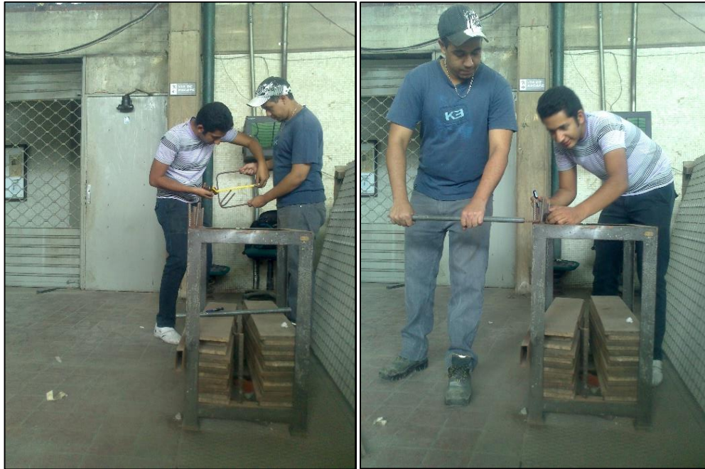
Figura 3.14 Doblado de Estribos
