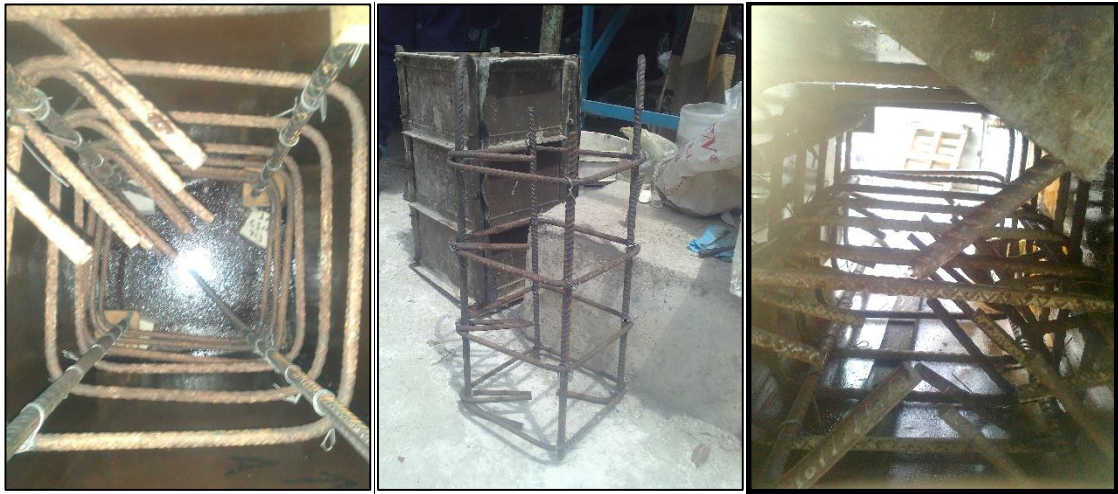
Figura 3.16 Armado del Acero
