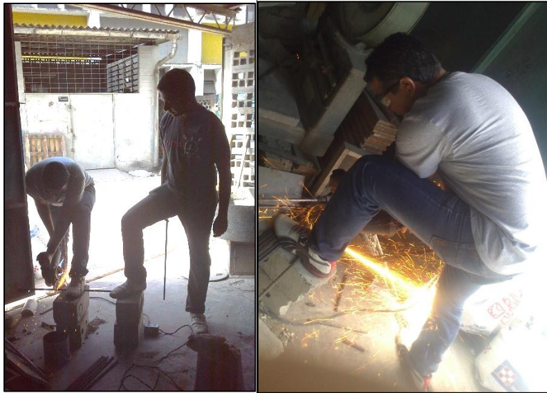
Figura 3.15 Corte de Barras \varnothing 1/2''
