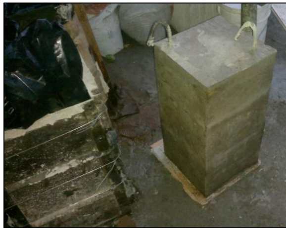
Figura 3.22 Desencofrado y Curado
