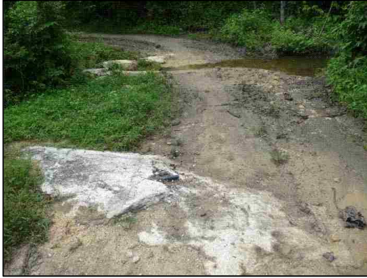
Figura D.76. Afloramiento en la carretera.
