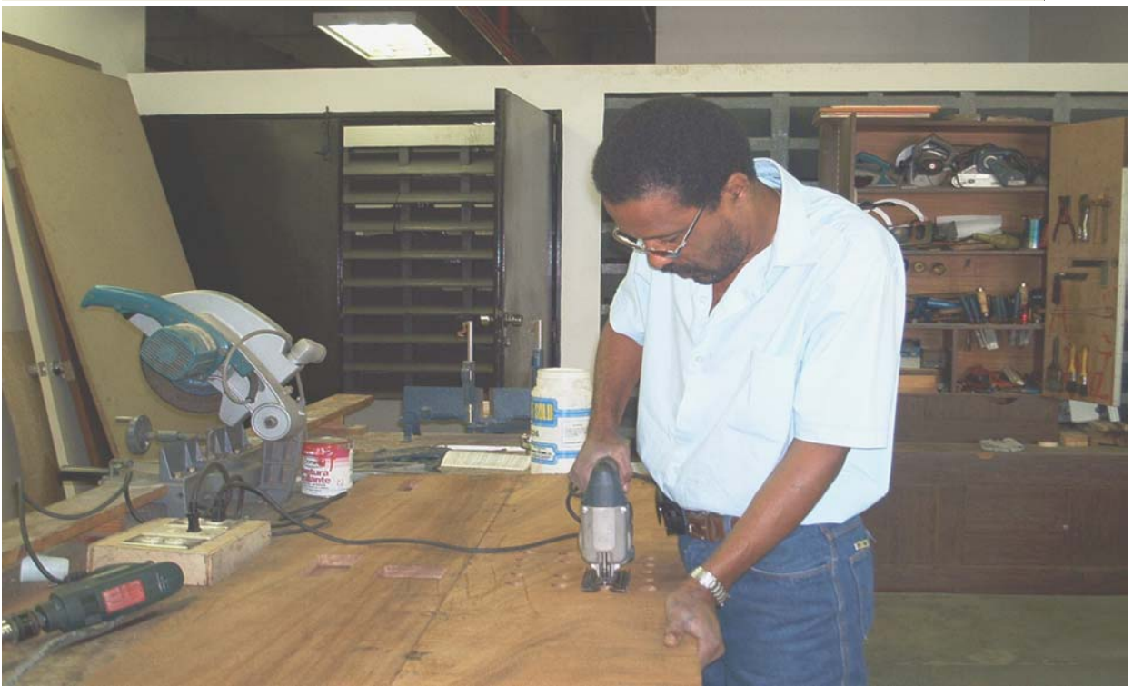
Figura 3.7 Construcción del mesón en los talleres.
