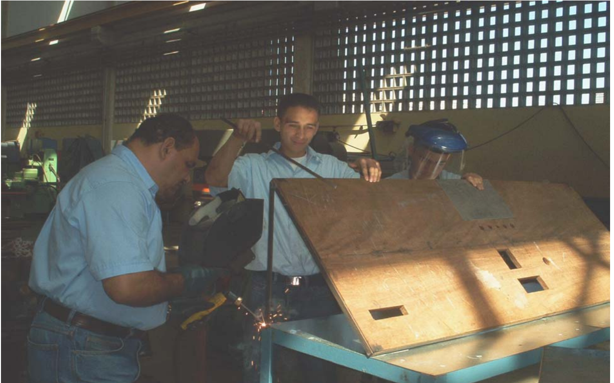
Figura 3.6 Construcción del banco en los talleres de Electro-mecánica
