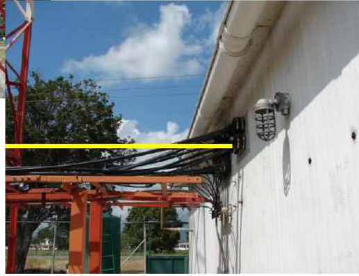
Vista del trayecto Torre – Caseta
