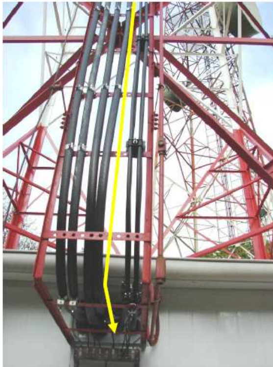
Vista del trayecto Torre – Caseta
