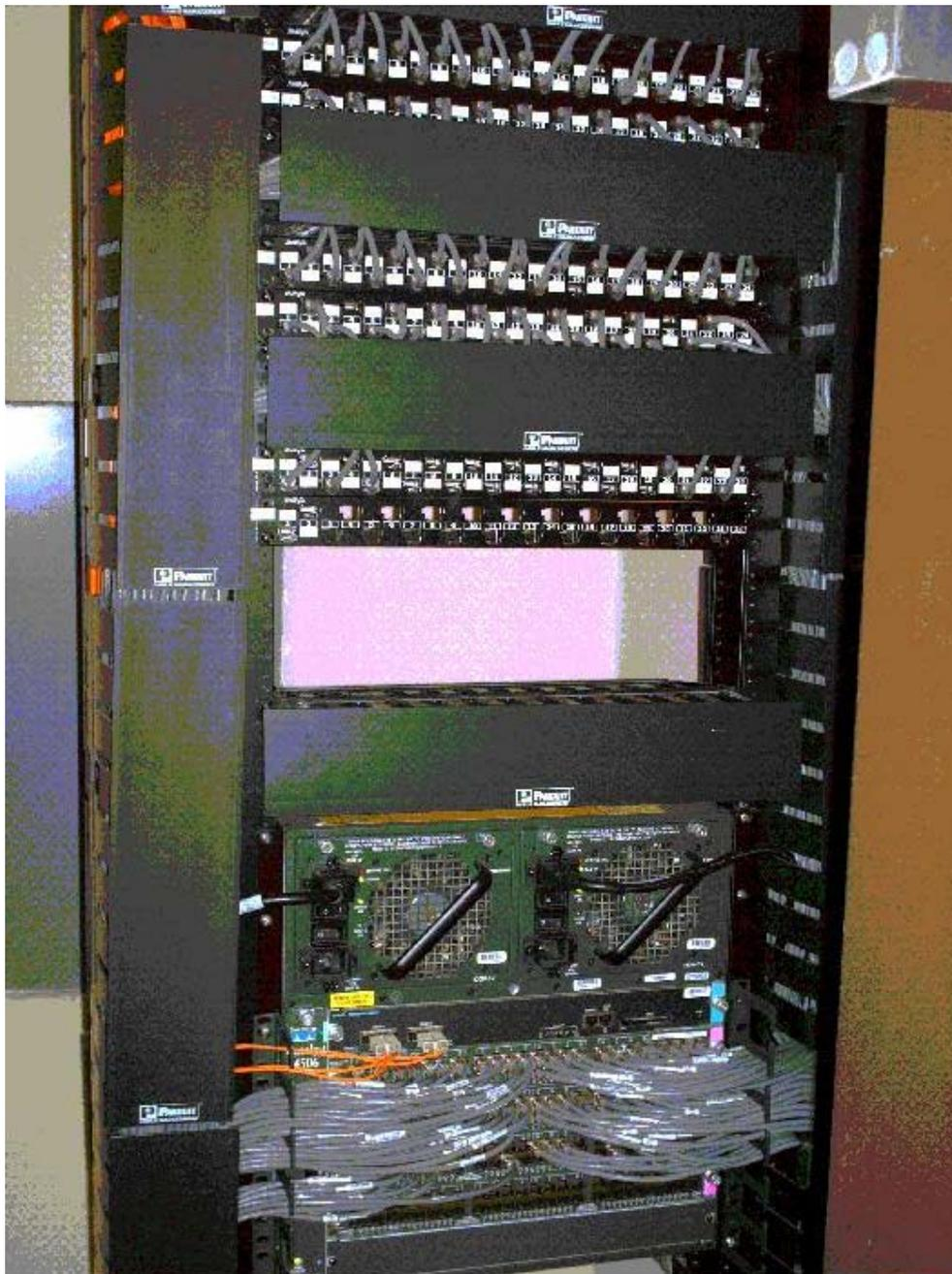
Switch 4506 y patch panel del cuarto de cableado piso 2 Edoval
