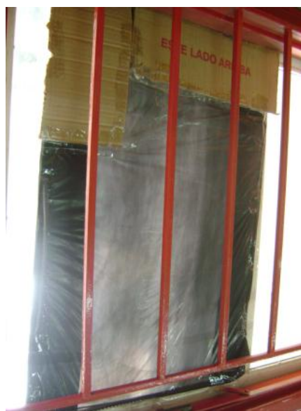
Figura D2-9. Reparaciones temporales para ventanas rotas
