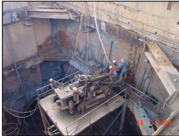
**Figura V.4.7.1** – Perforación de anclajes.
