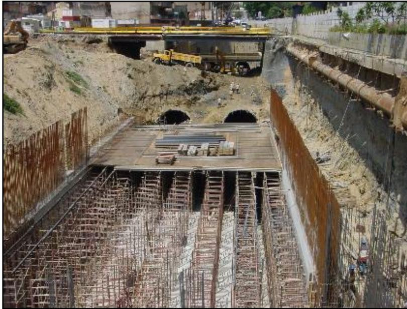
*Figura V.2.1.5- Excavación estación Parque Central
