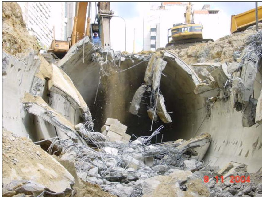
*Figura 2.3.1 – Demolición del túnel.
