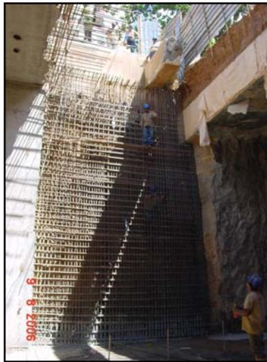
**Figura V.4.7.2 – Muro estructural interno.**
