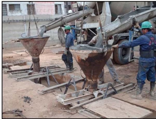
**Figura V.3.4.5** – Vaciado del Muro Colado.
