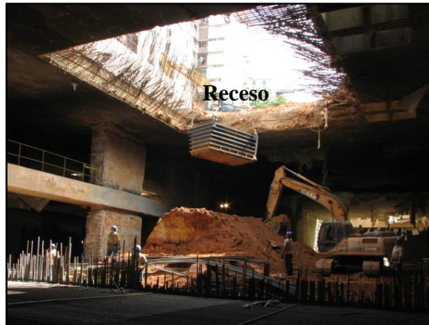
**Figura V.3.4.10** – Excavación Techo-Mezzanina.
