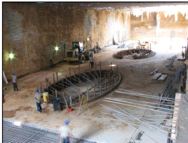
**Figura V.3.4.12 – Losa Mezzanina.**
