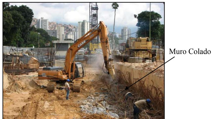
**Figura V.3.4.8 – Descabezamiento de Muro Colado.**
