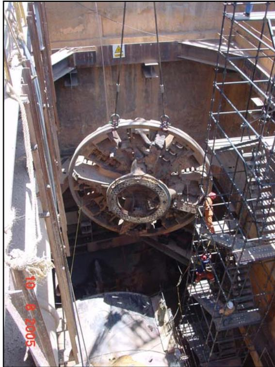
*Anexo 9 – Extracción de la Cabeza de corte de la TBM.
