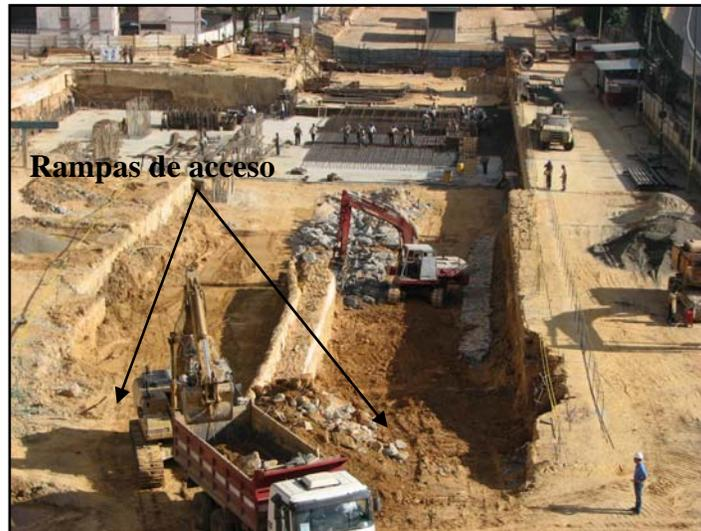
**Figura V.3.4.7 – Excavación Calle-Techo.**
