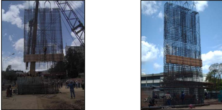
**Figura V.3.4.4** – Colocación de armaduras en muros colados.
