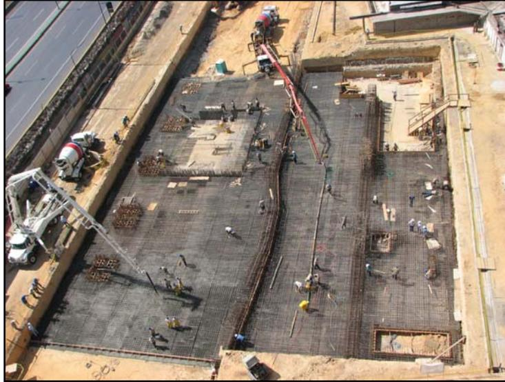
*Figura V.3.4.9 – Vaciado de la losa techo entre los ejes 3-9/A-D.
