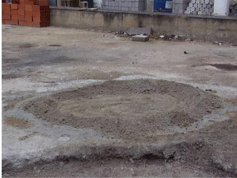
**Figura A2-9.** *Mezcla de cemento y arena*
