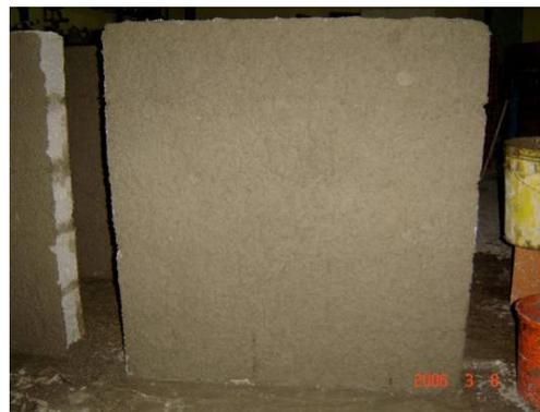
**Figura A3-26.** Friso Base en murete con bloques de concreto (salpicado)
