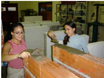
**Figura A3-21.** *Colocación de mortero superior*
