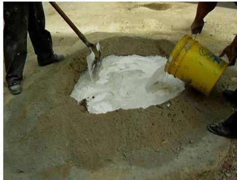
**Figura A2-11.** *Proporciones volumétricas medidas con cuñete*
