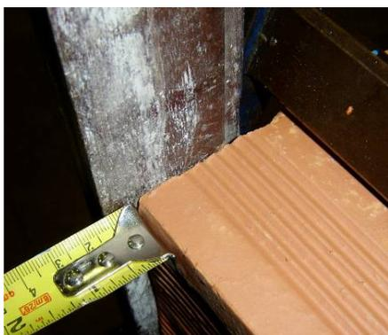
**Figura A3-25.** Espesor del Friso (1cm)
