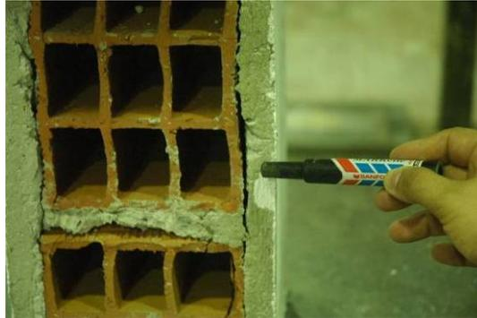
**Figura IV-17.** Fisura en la junta y desprendimiento del friso
