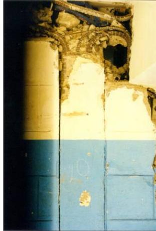
**Figura II-11:** *Efecto de columna corta donde se observa poco refuerzo transversal en las columnas para proporcionar el confinamiento adecuado*
