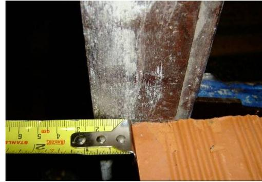
**Figura A3-14.** Espesor del Friso (2cm)
