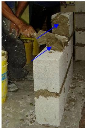
**Figura A3-23.** Juntas en Murete construido con bloques de concreto
