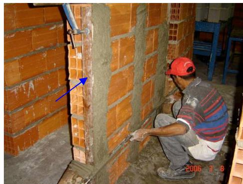
**Figura A3-24.** Listones de Madera, para fijar espesor del friso
