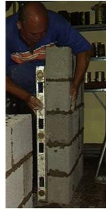
**Figura A3-18.** *Nivelación de las hiladas*
