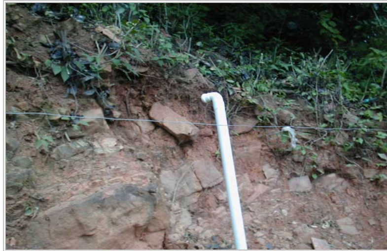
Figura 5.10: Tubo de ventilación
