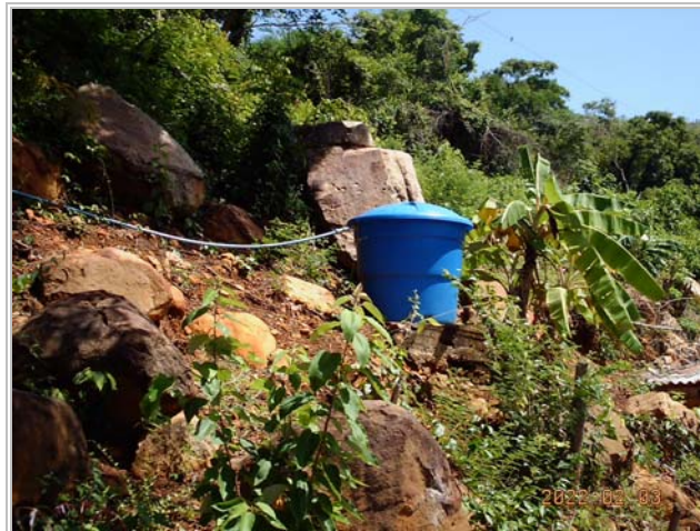
Figura 5.19: Tanques de almacenamiento en la franja costera de Petarito
