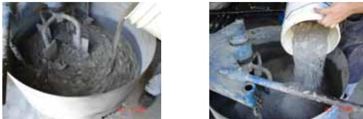
Figura 3.8. “Proceso de Mezclado”
