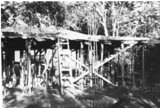
Figura 29. Encofrado de la techumbre de la casa del Arq. Julio Coll Rojas. . Fuente: Cortesía del Sr. Carlos Coll.
