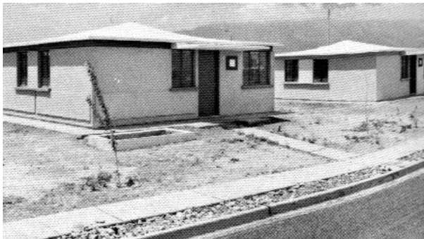
Figura 17. Viviendas de paraboloides hiperbólicos en forma de paraguas normal de la colonia Cuauhtémoc.
