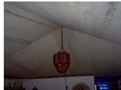
Figura 26. Detalle interno de la cubierta de paraboloides hiperbólicos en la casa del Arq. Julio Coll Rojas.. Fuente:Imágenes del autor.
