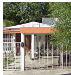
Figura 19. Casa de la calle Titán No 113, la cual conserva el techo de paraboloides hiperbólicos en forma de paraguas normal diseñado por Candela.
