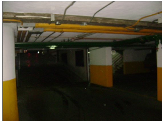
Figura B.19.6: Columnas en el Sótano 2
