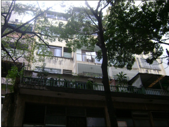
Figura B.15.3: Fachada Este (principal)
