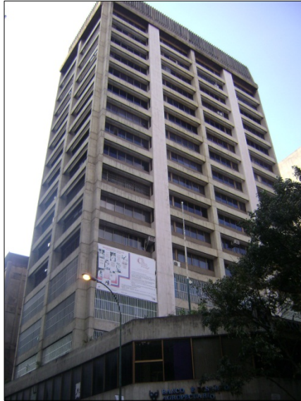
Figura B.25.3: Fachada Este (principal)
