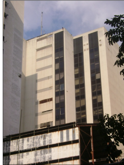
Figura B.19.4: Fachada Oeste (posterior)
