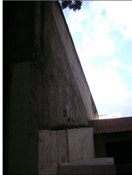
Figura B.20.4: Fachada Sur (lateral)
