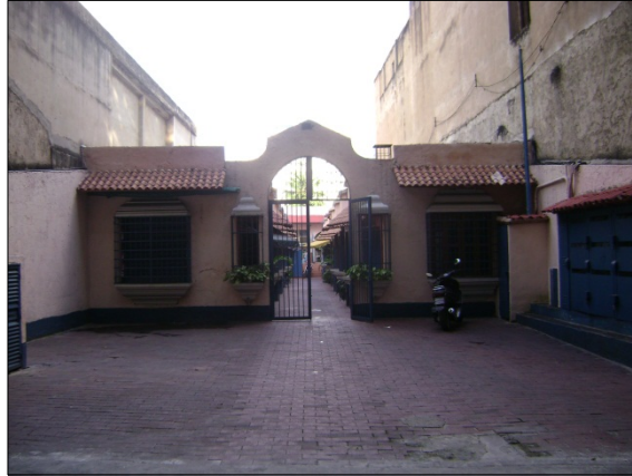
Figura B.21.3: Fachada Oeste (principal)
