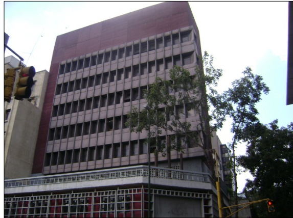
Figura B.39.4: Fachada Sur (principal), en plantas superiores
