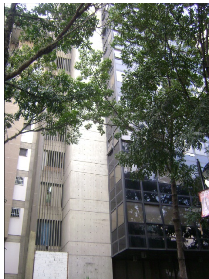
Figura B.29.6: Fachada Este en límite con el Edificio San José
