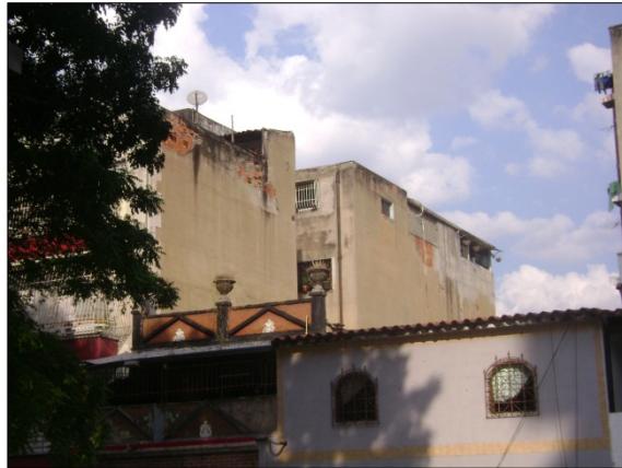
Figura B.9.4: Fachada Sur (lateral)
