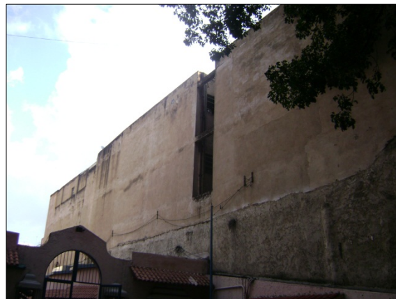
Figura B.22.5: Fachada Norte (lateral)
