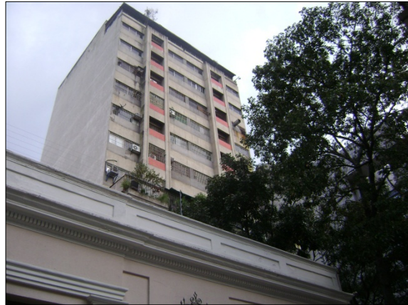
Figura B.38.4: Fachada Oeste (principal), en plantas superiores
