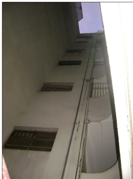
Figura B.16.6: Fachadas Internas
