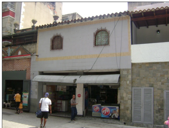
Figura B.11.4: Fachada Oeste (principal), desde otro ángulo
