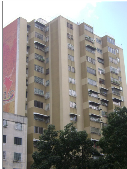
Figura B.5.4: Fachada Oeste (principal)
