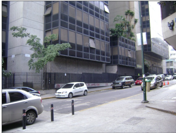
Figura B.29.5: Fachada Norte (lateral) en Planta Baja
