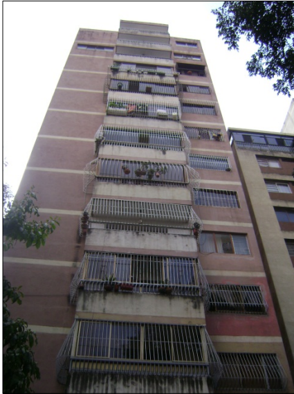
Figura B.8.3: Fachada Este (principal)
