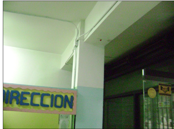
Figura B.6.4: Viga en voladizo vista a la izquierda de la Columna
