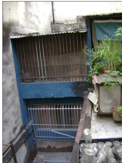
Figura B.15.6: Construcciones en la Planta Mezzanina
