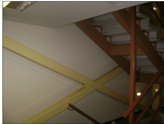
Figura B.34.5: Núcleo de Escaleras y Arriostramiento con Perfiles de Acero
