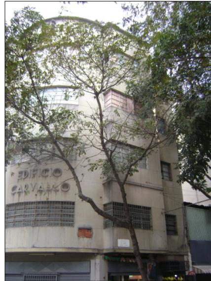
Figura B.14.4: Fachada Oeste (principal)
