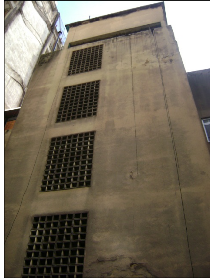
Figura B.15.4: Fachada Oeste (posterior)
