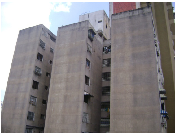
Figura B.2.5: Fachada Norte (lateral)
