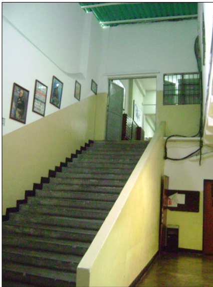
Figura B.20.5: Escalera entre Planta Baja y Sótano
