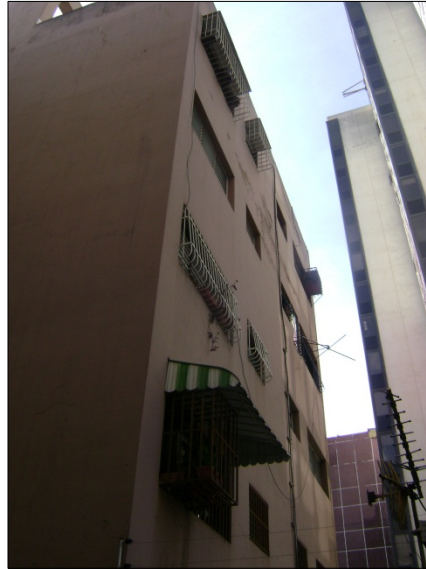
Figura B.17.4: Fachada Oeste (posterior)
