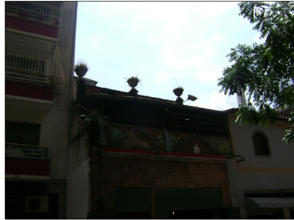
Figura B.10.4: Nivel Superior en Fachada Oeste
