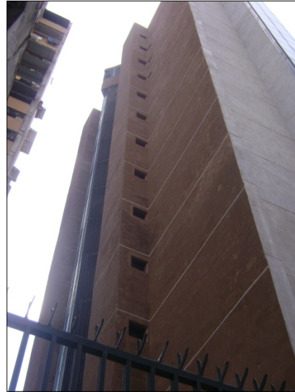
Figura B.1.4: Fachada Sur (posterior)
