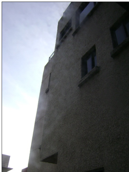
Figura B.31.5: Parte de Fachada Este (posterior)
