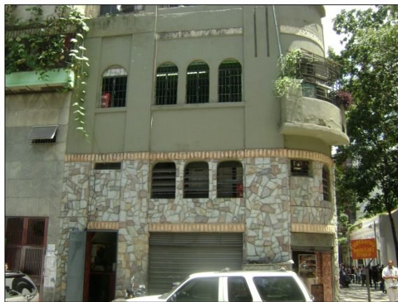
Figura B.30.4: Fachada Norte (principal)
