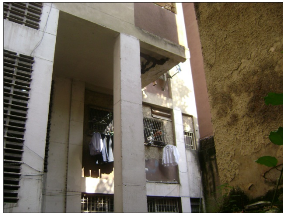
Figura B.7.6: Columna de doble altura en Fachada Oeste
