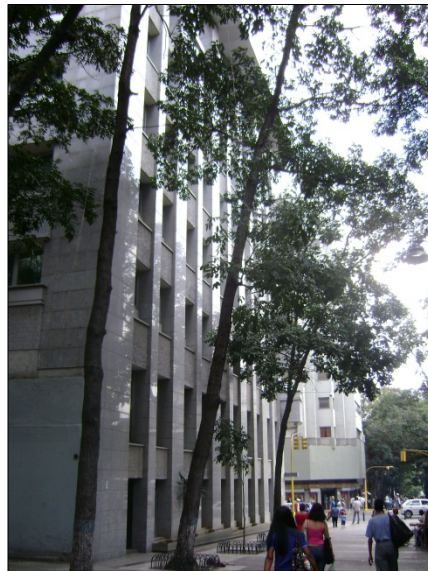
Figura B.40.5: Fachada Oeste (lateral)
