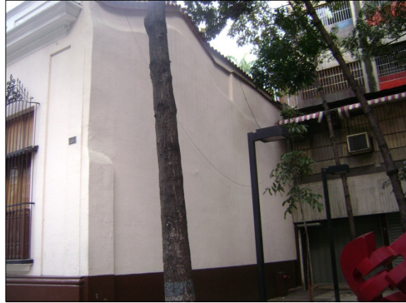
Figura B.33.4: Fachada Sur (lateral)
