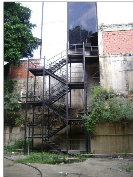
Figura B.1.6: Fachada Oeste (lateral) y Escalera Metálica hacia el nivel del Sótano 2
