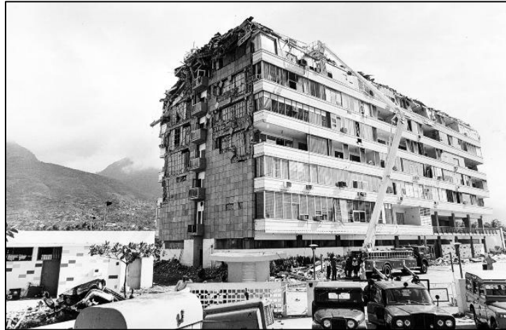
Figura I.2: Colapso Parcial de un Edificio ubicado en Caraballeda, Litoral Central, luego del Terremoto del 29 de julio de 1967
