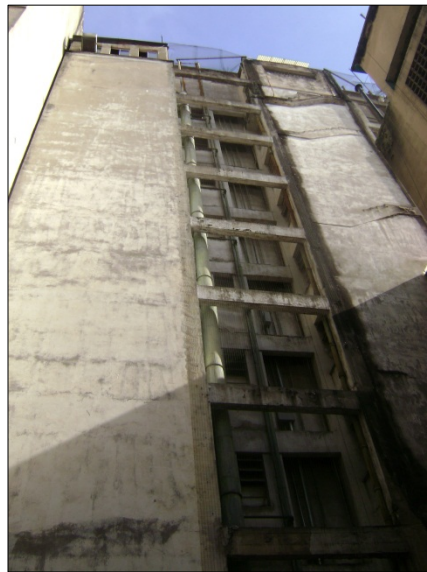
Figura B.13.5: Fachada Sur (posterior)
