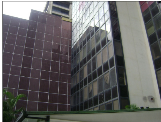
Figura B.23.5: Fachada Norte (lateral), a la izquierda del Edificio de la Defensa Pública
