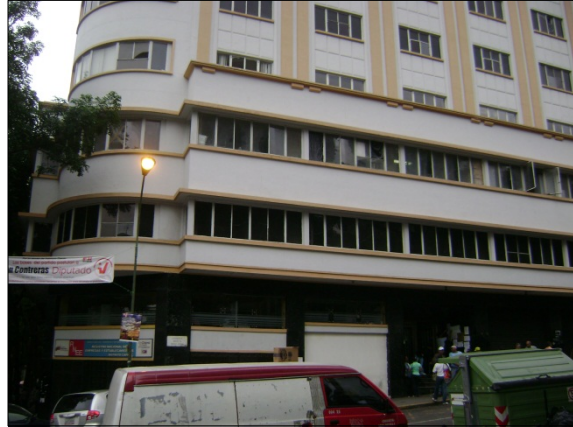
Figura B.13.4: Fachada Norte (principal), a nivel de la Entrada
