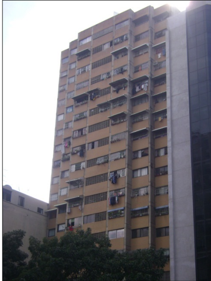
Figura B.4.3: Fachada Este (principal)
