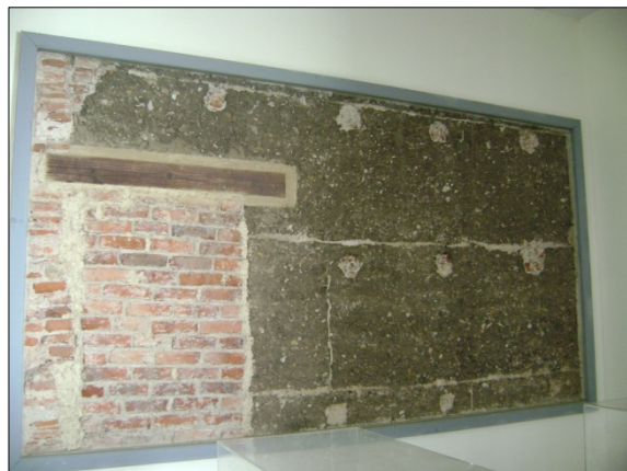
Figura B.35.6: Detalle de Mampostería perimetral de la Casa
