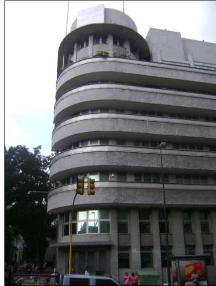
Figura B.40.4: Fachada Norte (lateral)
