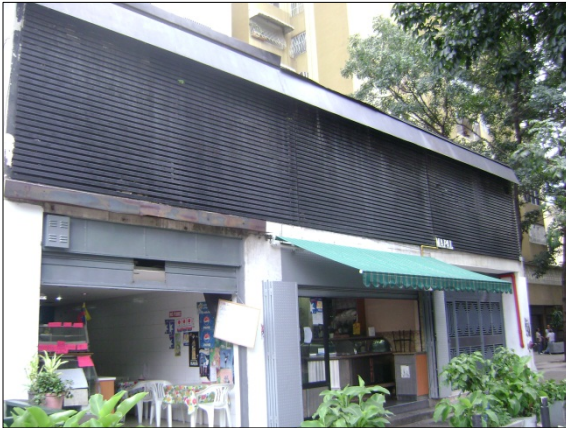
Figura B.3.3: Fachada Oeste (principal)
