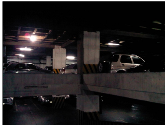
Figura B.25.6: Columnas, Vigas y Losas Reticuladas en Sótanos 1 y 2
