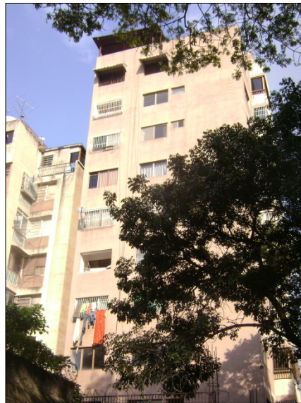
Figura B.8.5: Fachada Oeste (posterior)
