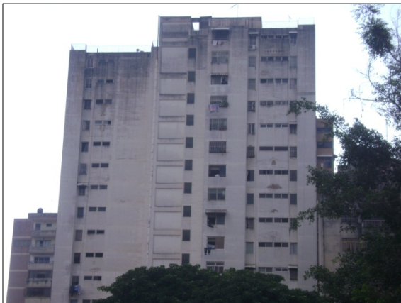
Figura B.5.5: Fachada Oeste (posterior)
