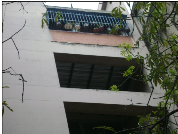
Figura B.17.5: Extensión de Balcones hacia el borde de la Fachada Este
