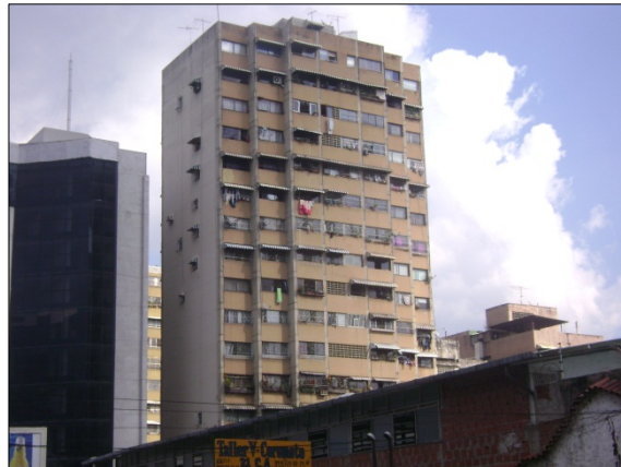
Figura B.4.6: Fachada Oeste (posterior)
