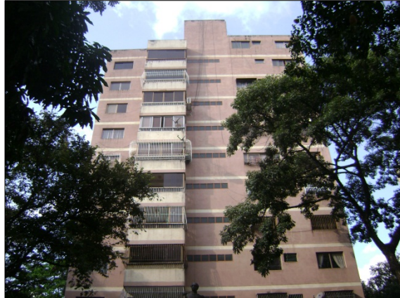
Figura B.8.4: Fachada Sur (lateral)
