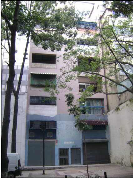
Figura B.17.3: Fachada Este (principal)
