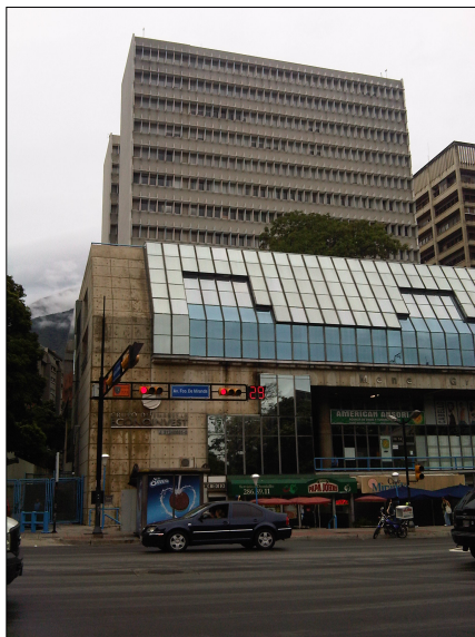
Figura V.5: Fachada Sur (principal) del Edificio Mene Grande Empresarial (detrás del Comercial)
