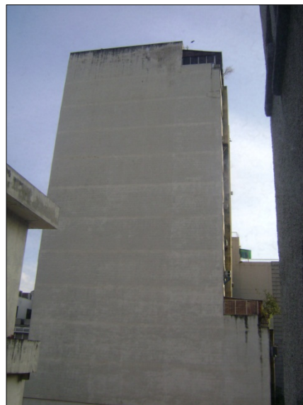
Figura B.38.5: Fachada Norte (lateral)
