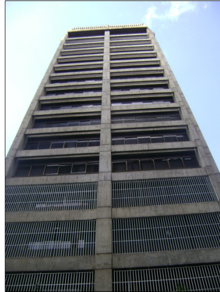
Figura B.25.4: Fachada Sur (lateral)
