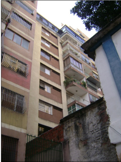
Figura B.7.3: Fachada Este (principal)
