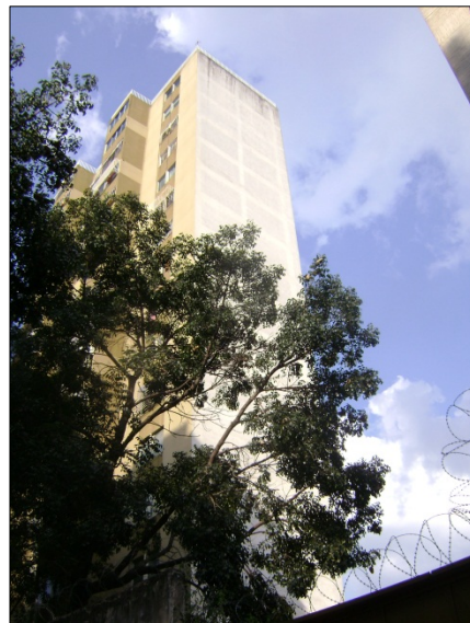
Figura B.5.6: Fachada Sur (lateral)
