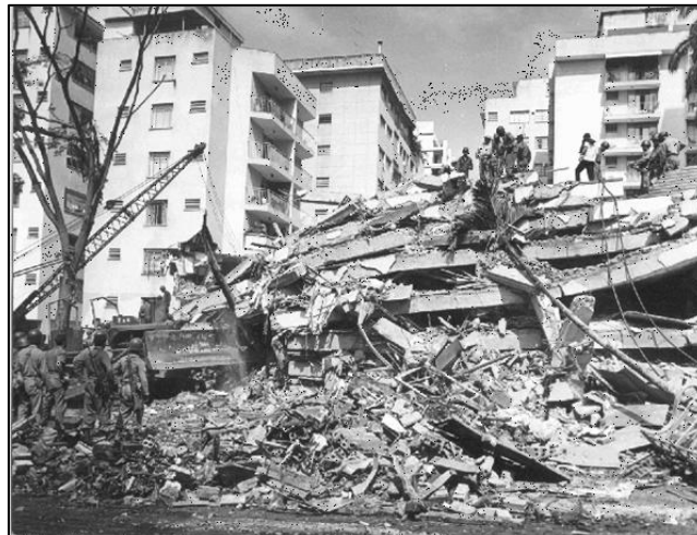
Figura I.1: Restos del Edificio Mijagual en la Urbanización Los Palos Grandes en Caracas, luego del Terremoto del 29 de julio de 1967
