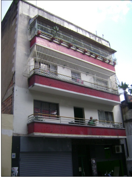
Figura B.9.3: Fachada Oeste (principal)
