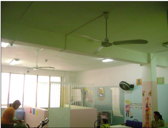
Figura B.6.5: Espacio interior con columnas libres en Nivel PB
