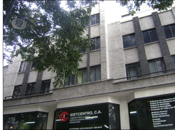
Figura B.31.4: Fachada Oeste (principal), en plantas Superiores
