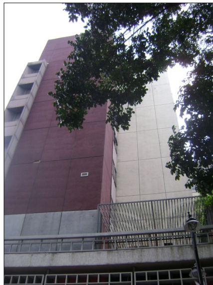
Figura B.38.5: Fachada Este (lateral)
