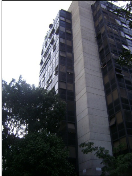
Figura B.29.3: Fachadas Este (principal) y Norte
