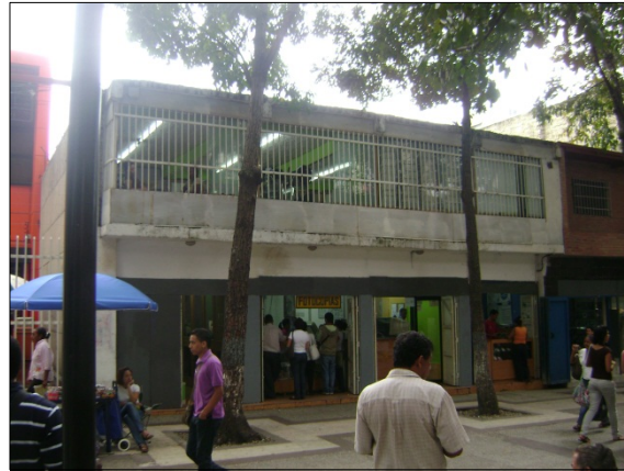
Figura B.26.3: Fachada Oeste (principal)
