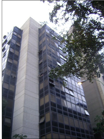
Figura B.29.4: Fachada Norte (lateral)
