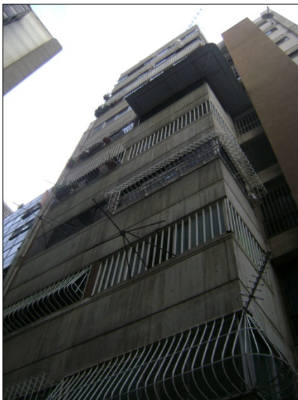
Figura B.32.5: Fachada Oeste (posterior)
