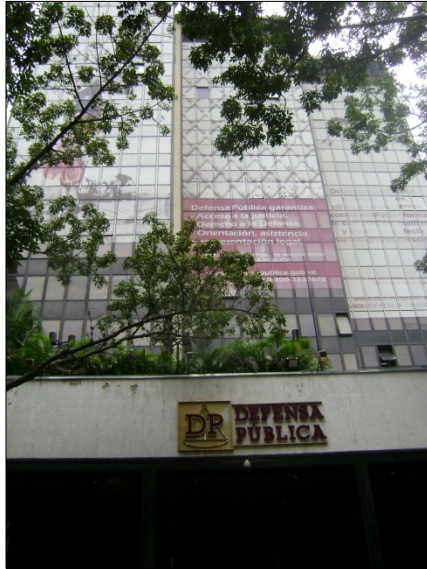
Figura B.19.3: Fachada Este (principal)
