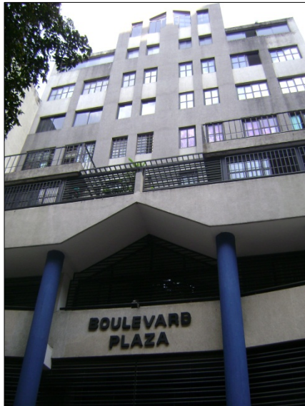
Figura B.18.3: Fachada Oeste (principal)
