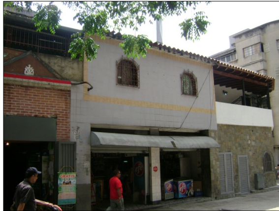
Figura B.11.3: Fachada Oeste (principal)
