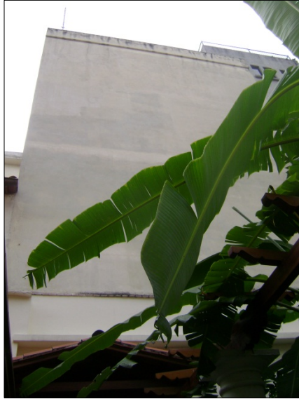
Figura B.34.3: Fachada Este (principal)
