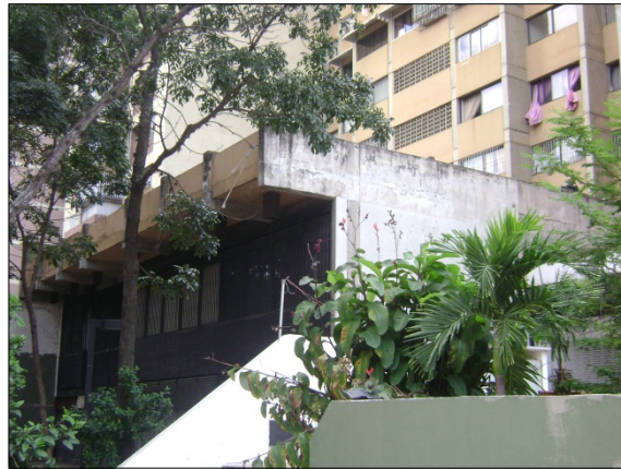
Figura B.4.4: Fachada Este (principal) y Terraza de la Planta Mezzanina
