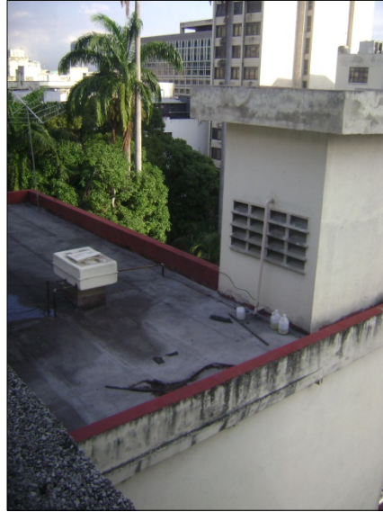
Figura B.34.4: Sala de Máquinas y Techo
