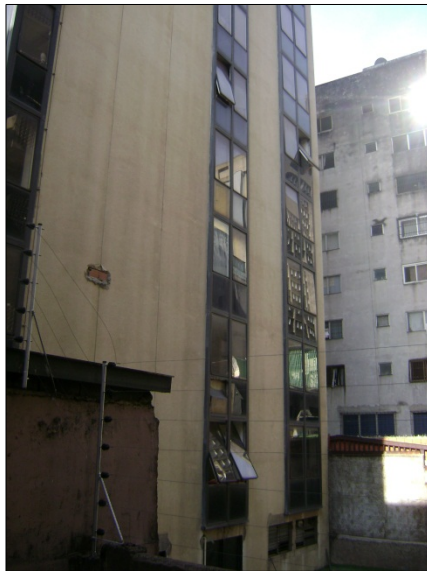
Figura B.19.5: Fachada Norte (lateral)
