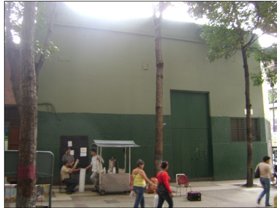
Figura B.28.3: Fachada Oeste (principal)
