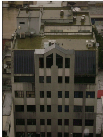
Figura B.18.4: Fachada Oeste y Techo
