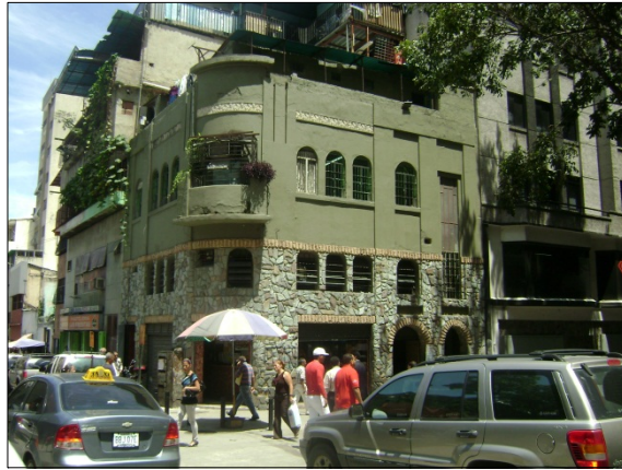
Figura B.30.3: Fachada Oeste (principal)
