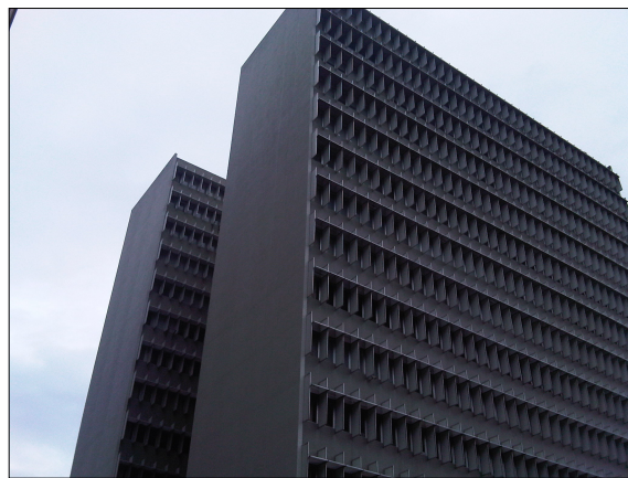
Figura V.6: Fachadas Norte (posterior) y Este (lateral) del Edificio Mene Grande Empresarial
