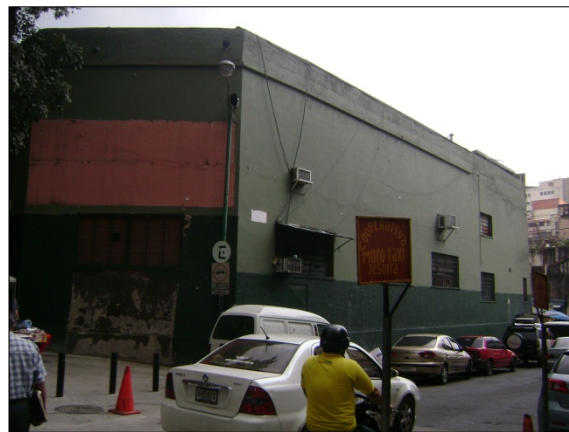
Figura B.28.4: Fachada Sur (lateral)
