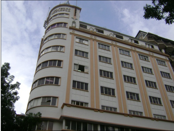
Figura B.13.3: Fachada Norte (principal)
