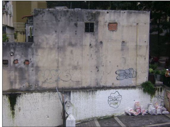
Figura B.3.3: Fachada Norte (lateral)
