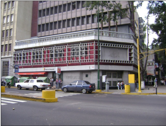
Figura B.39.3: Fachada Sur (principal), en Planta Baja y Mezzanina
