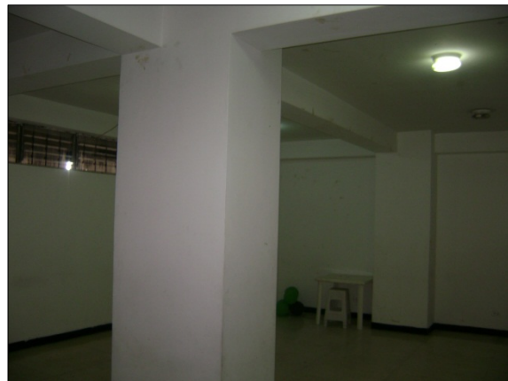
Figura B.32.6: Columnas y Vigas en Salón de Fiestas
