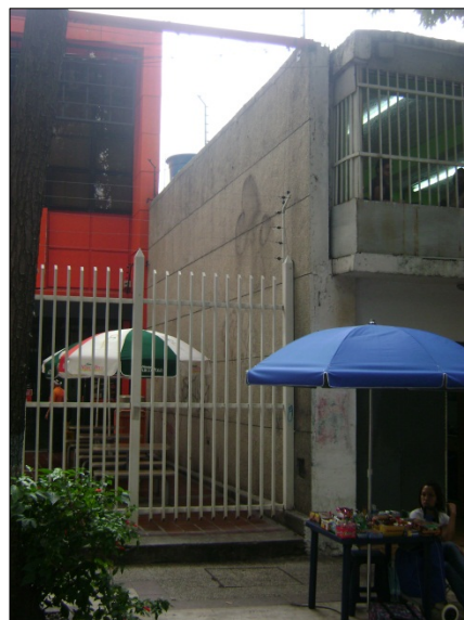
Figura B.26.4: Fachada Norte (lateral)
