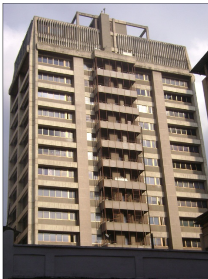
Figura B.25.5: Fachada Oeste (posterior)
