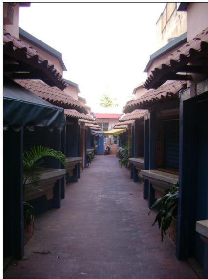
Figura B.21.4: Pasillo Interno de Locales Comerciales
