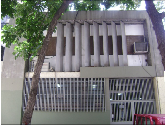
Figura B.20.3: Fachada Oeste (principal)
