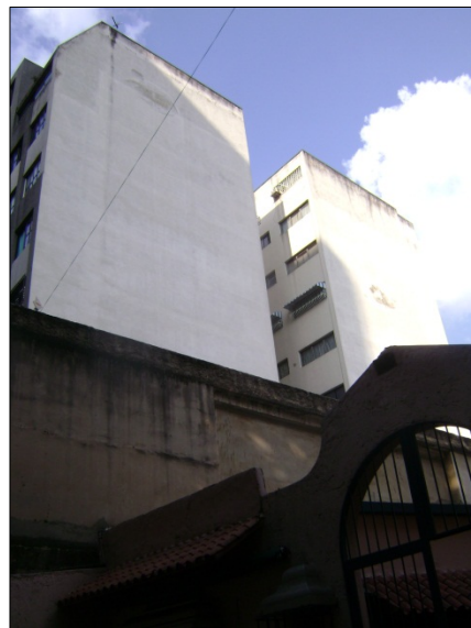
Figura B.18.5: Fachada Sur (lateral)
