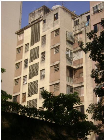
Figura B.7.5: Fachada Oeste (posterior)
