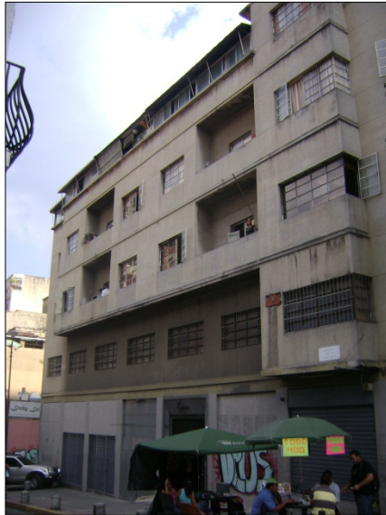
Figura B.14.3: Fachada Norte (principal)
