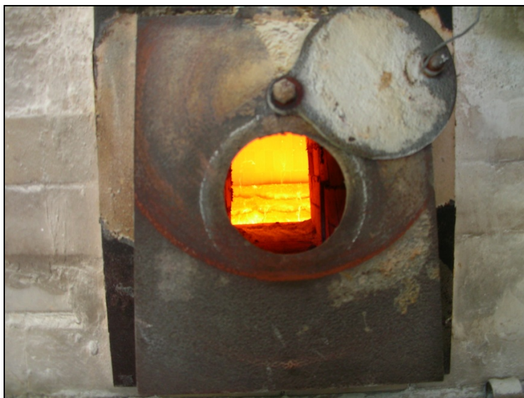
Figura (4.3), impianto di Moncucco: vista del forno.
