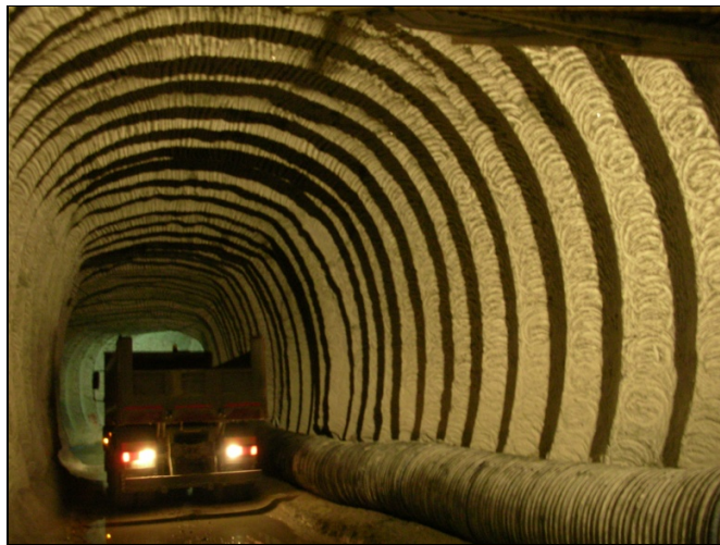
Figura (5.2): sezione di scavo della galleria a Moncucco; si notano le tracce lasciate dalla fresa sulla roccia.
