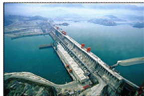
Presajion Yin Presade concreto gravedad
