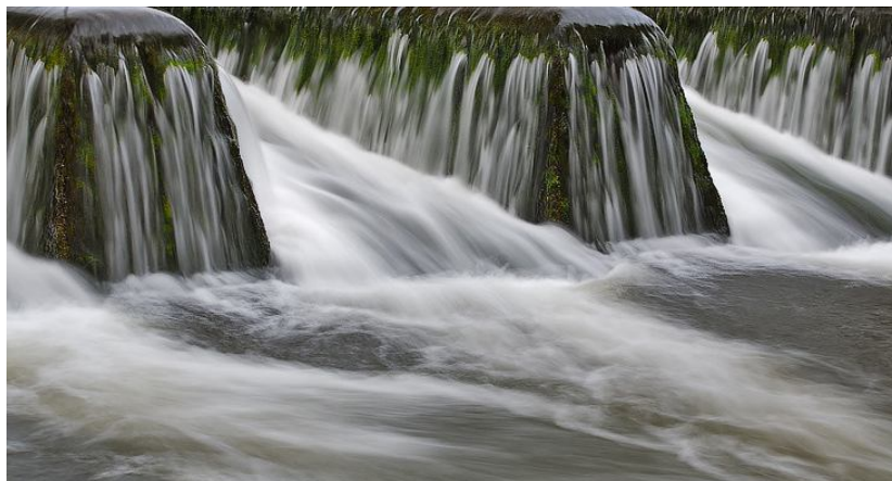
Figura III.17 Vista en detalle de la descarga de un Vertedero de Laberinto (River Chees)
