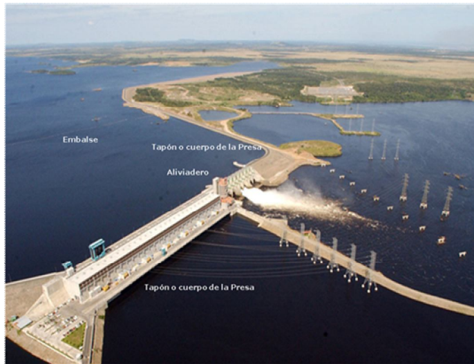
Figura II.2 elementos de una presa
