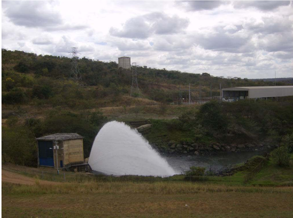
Figura 7. Vista de la válvula reguladora Howell-Bunger descargando un caudal de 5 m 3 /s, usada para la descarga de fondo del embalse Pao La Balsa, principalmente para mantener el caudal ecológico del río Pao aguas abajo de la presa.
