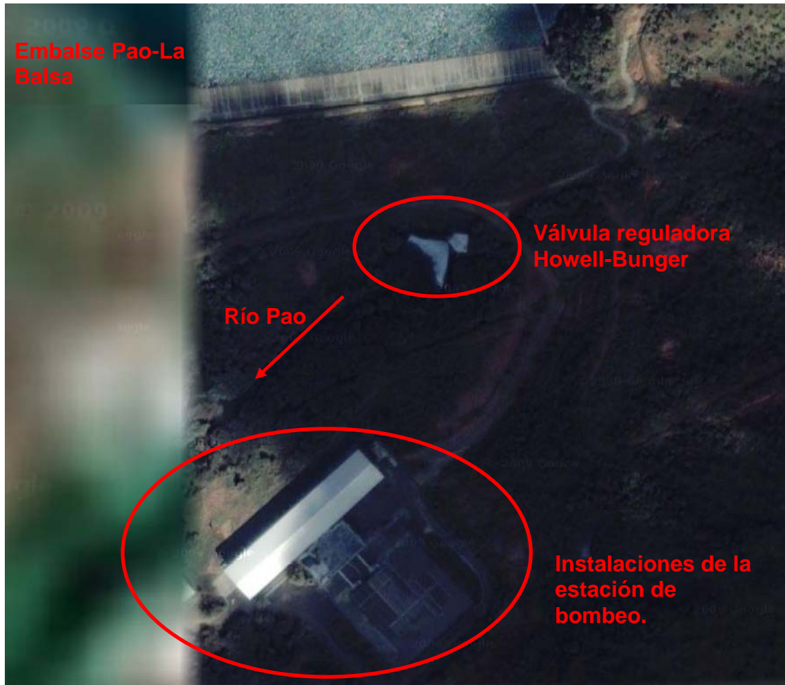
Figura 6. Zona de estudio para el levantamiento topográfico donde se muestra la estación de bombeo, adyacente al río Pao, que puede ser afectada por algún evento extremo. También, se observa la válvula reguladora Howell-Bunger y embalse Pao-La Balsa.
