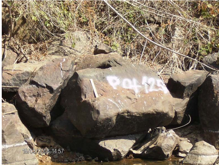
Figura 27. Margen izquierda del río Pao en la progresiva 0+125, donde se observa gran proporción por peñones de D = 1.00 a 3.00 m aproximadamente.
