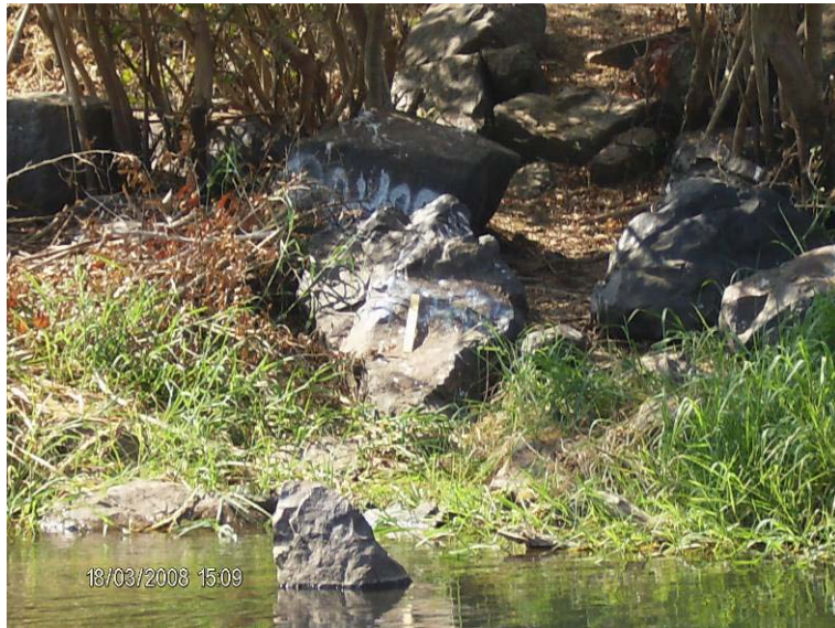
Figura 28. Margen derecha, progresiva 0+125. Los cantos rodados y peñones que componen ambas márgenes del río llegan a abarcar parte del lecho reduciendo la sección transversal en este sub-tramo.
