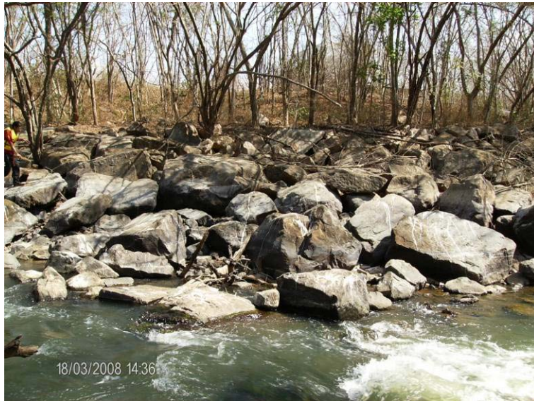
Figura 29. Margen Izquierda, progresiva 0+040. El enrocado de protección es visible para ambas márgenes en la zona próxima a la válvula reguladora Howell Bunger y continúa por el talud de la margen izquierda del río adyacente a la estación de bombeo.
