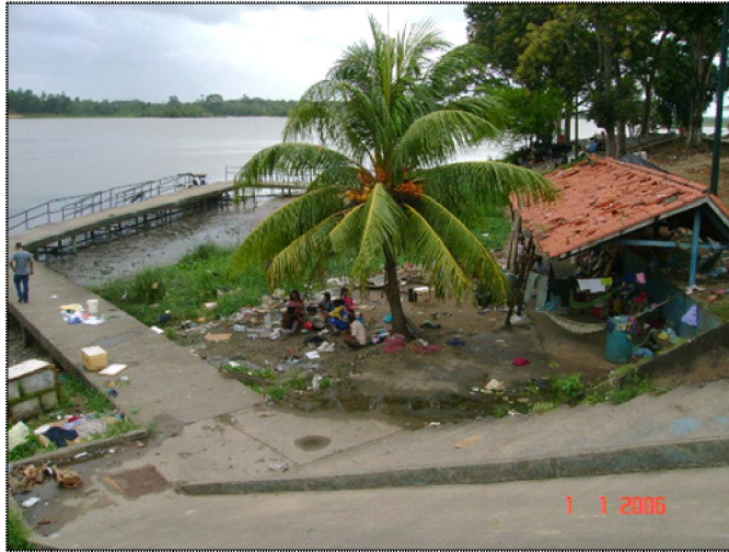
Figura N° 11. Vista general muelle de la Alcaldía Fuente propia
