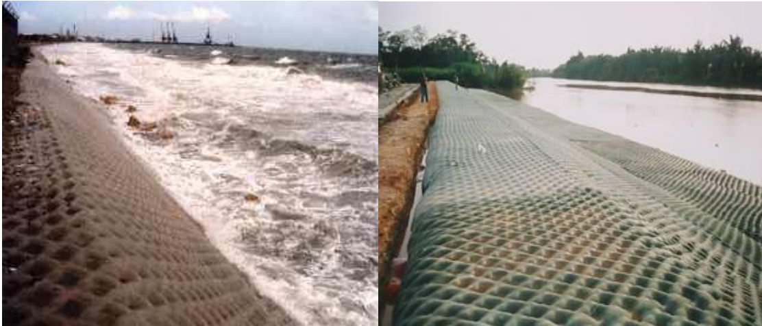
a N° 65. Lonas colocadas en costas Fuente. Revetment system Latín America
