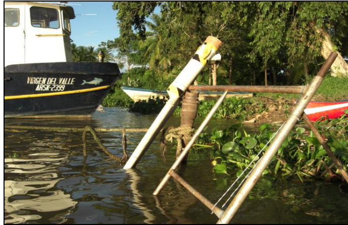
Figura N° 46. Equipo instalado Fuente: Elaboración Propia
