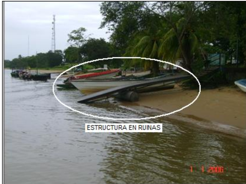
Figura N° 9. Vista lateral del actual muelle Fuente: Elaboración propia
