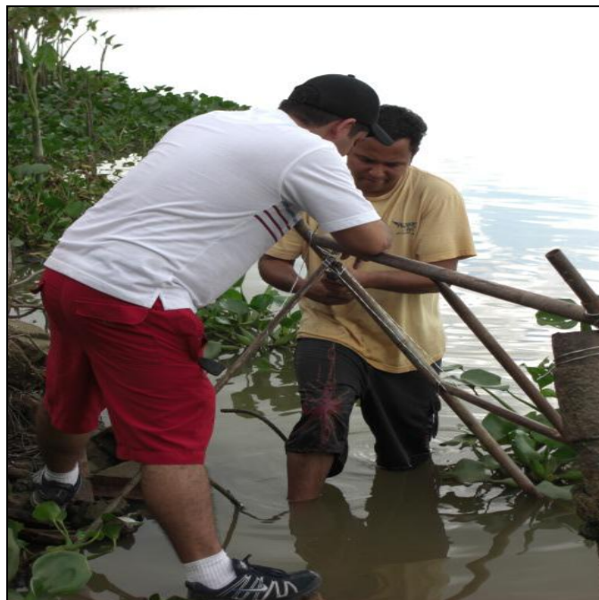
Figura N° 45. Instalación de andamio para colocación de equipo Fuente: Elaboración Propia
