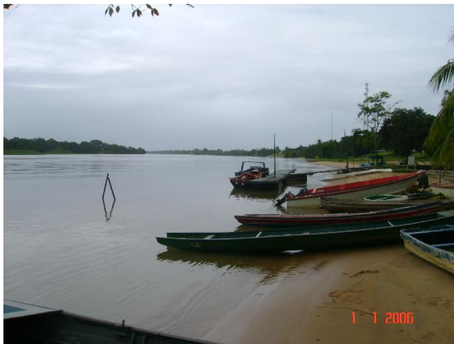
Fotografía N° 55. Vista lateral de estructura del muelle que aun flota Fuente propia
