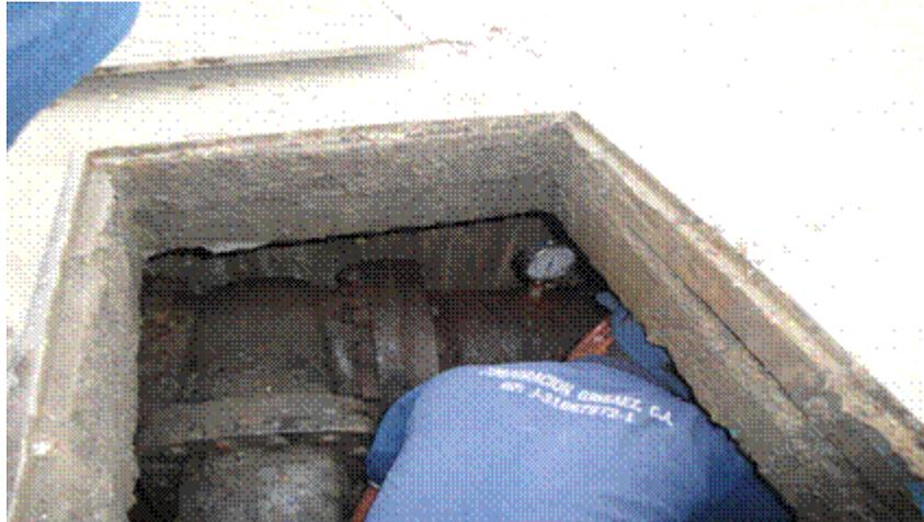
Figura.III.3. Colocación de manómetro sobre el ASFM para la medición de presión. Nodo 6
