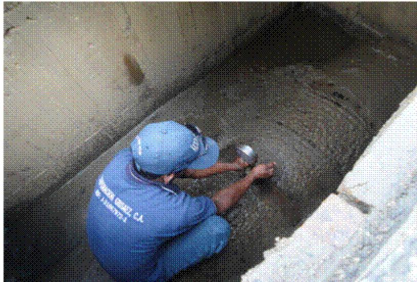
Figura.III.1. Colocación de manómetro sobre el ASFM para la medición de presión.
