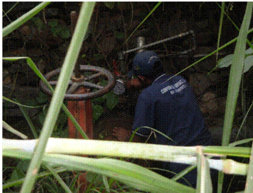
Figura.III.4. Colocación de manómetro sobre el ASFM para la medición de presión. Nodo 24
