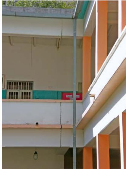
**Imagen A-06.** Vista sur. Juntas de separación.
