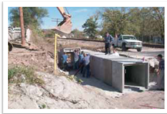
Imagen 1.1. Fase de construcción del Puente Box Culvert, Rolla MO. USA. Fuente: http://www.hughesbros.com/Aslan100/Aslan100_GFRP_rebar.html
