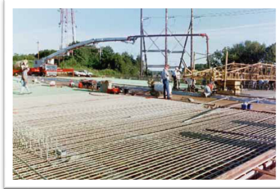
Imagen 1.3. Fase de construcción del Puente de la Avenida 53. Los Angeles, USA. Fuente: http://www.hughesbros.com/Aslan100/Aslan100_GFRP_rebar.html
