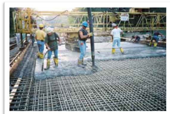
Imagen 1.4. Fase de construcción del Puente Miles Road, Ohio, USA. Fuente: http://www.hughesbros.com/Aslan100/Aslan100_GFRP_rebar.html
