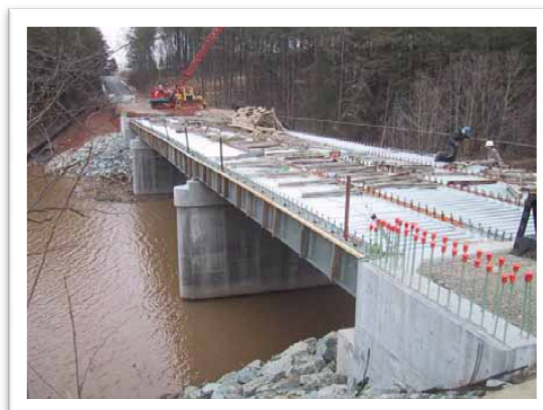
Imagen 1.5. Fase de construcción del Puente Franklin County, Virginia, USA. Fuente: http://www.hughesbros.com/Aslan100/Aslan100_GFRP_rebar.html
