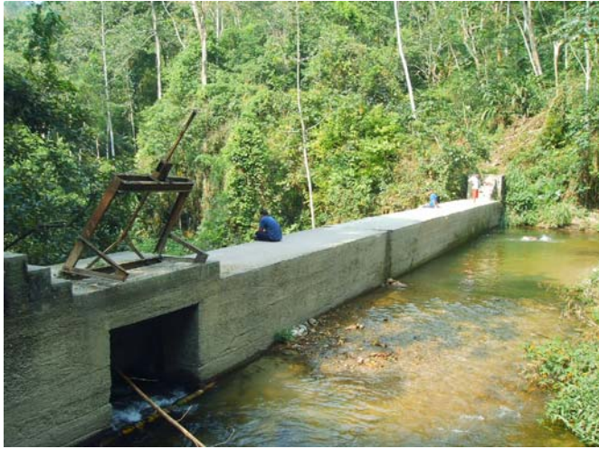
Figura 4. 9 Vista interna del dique sedimentado y el aliviadero
