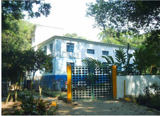
Figura 4. 19 Vista externa de la casa de maquinas
