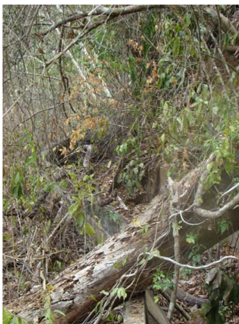
Figura 4. 13 Tramo de canal destruido
