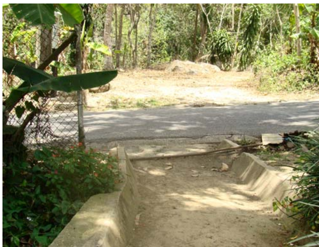
Figura 4. 12 Canal atravesado por la carretera de acceso a Choroni
