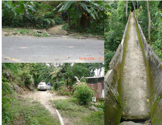
Figura 4. 11 Tramo de canal sepultado y vista del puente canal
