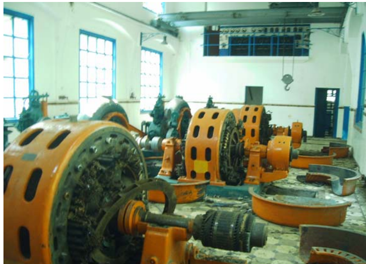
Figura 4. 20 Equipos electromecánicos desmantelados
