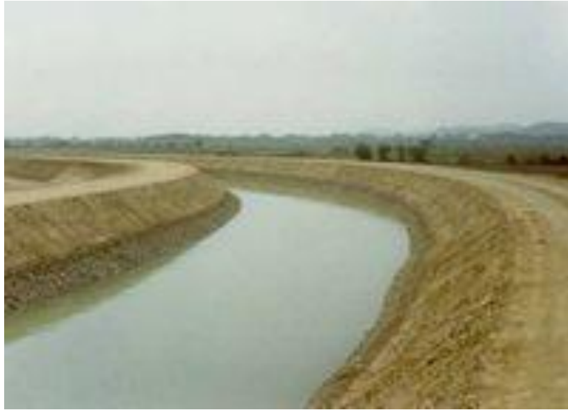
Canal de Riego (Sin revestimiento)
