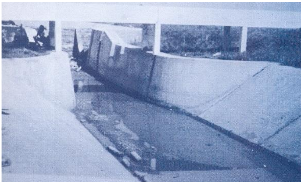
Canal trapecial con transición a rectangular
