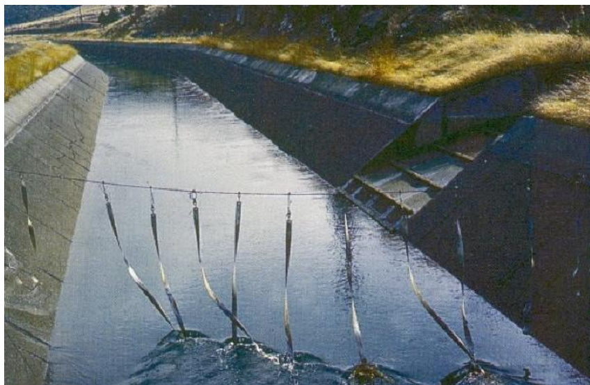
Canal de Riego trapecial
