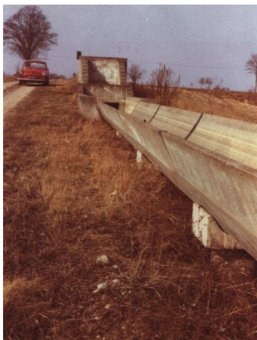
Canal elevado con caída
