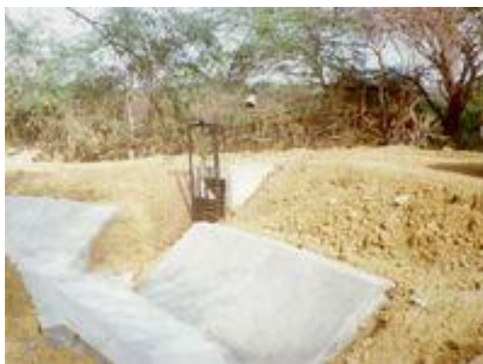
Construcción de canal de riego (trapezoidal)
