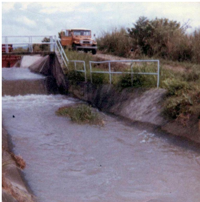
Canal Trapecial con transición a rectangular
