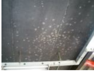
Figura C1-1. Techo de la Planta Baja del Edificio Trasbordo
