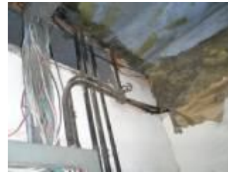
Figura C1-10. Entrada de aire al cuarto de la U.M.A de planta baja
