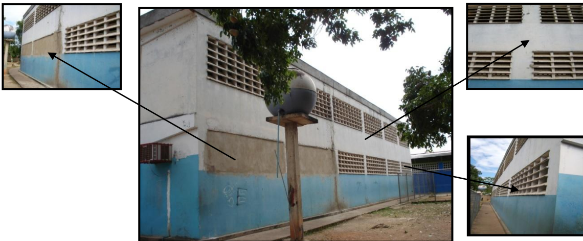
Figura IV.3.4 Fachada Norte del módulo
