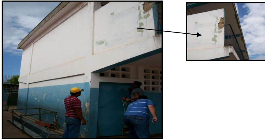
Figura IV.3.5. Fachada Oeste del módulo Fuente: Elaboración Propia
