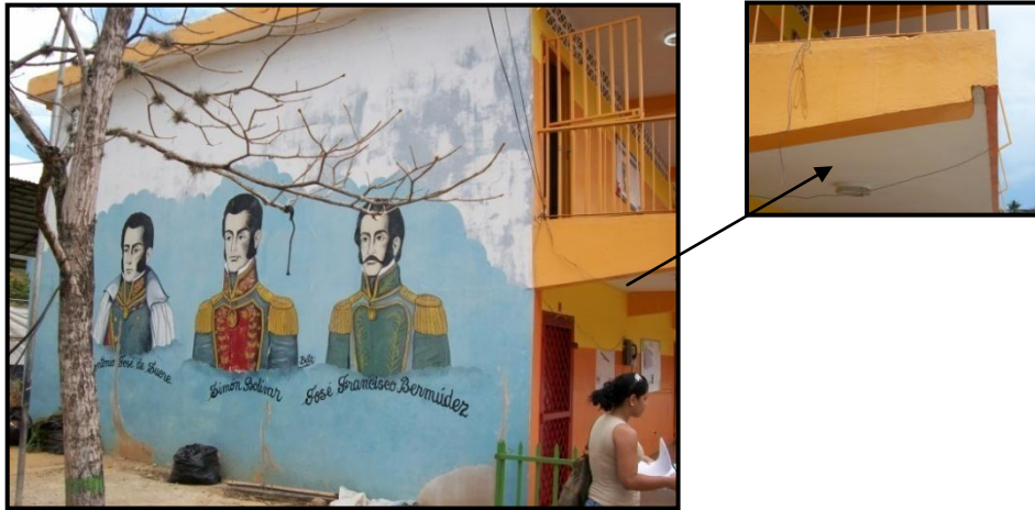
Figura IV.2.5. Fachada Oeste del módulo I Fuente: Elaboración Propia
