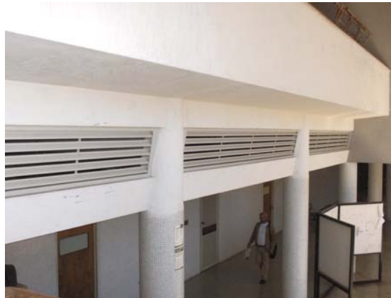
Figura II.2.12 Entrepiso Intermedio Existente en Planta Baja del Edificio Principal
