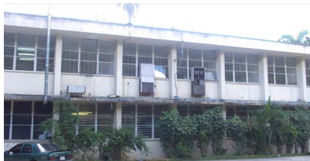
Figura II.2.9 Fachada Norte del Edificio Principal del Instituto de Medicina Tropical Dr. Félix Pifano
