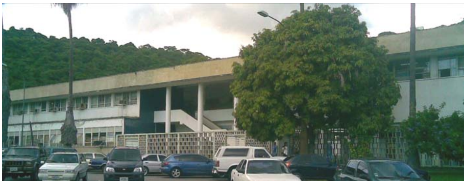
Figura II.2.7 Fachada Sur - Pabellón Este del Edificio Principal del Instituto de Medicina Tropical Dr. Félix Pifano
